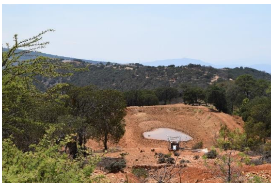
Jagüey para Captar Agua Pluvial
