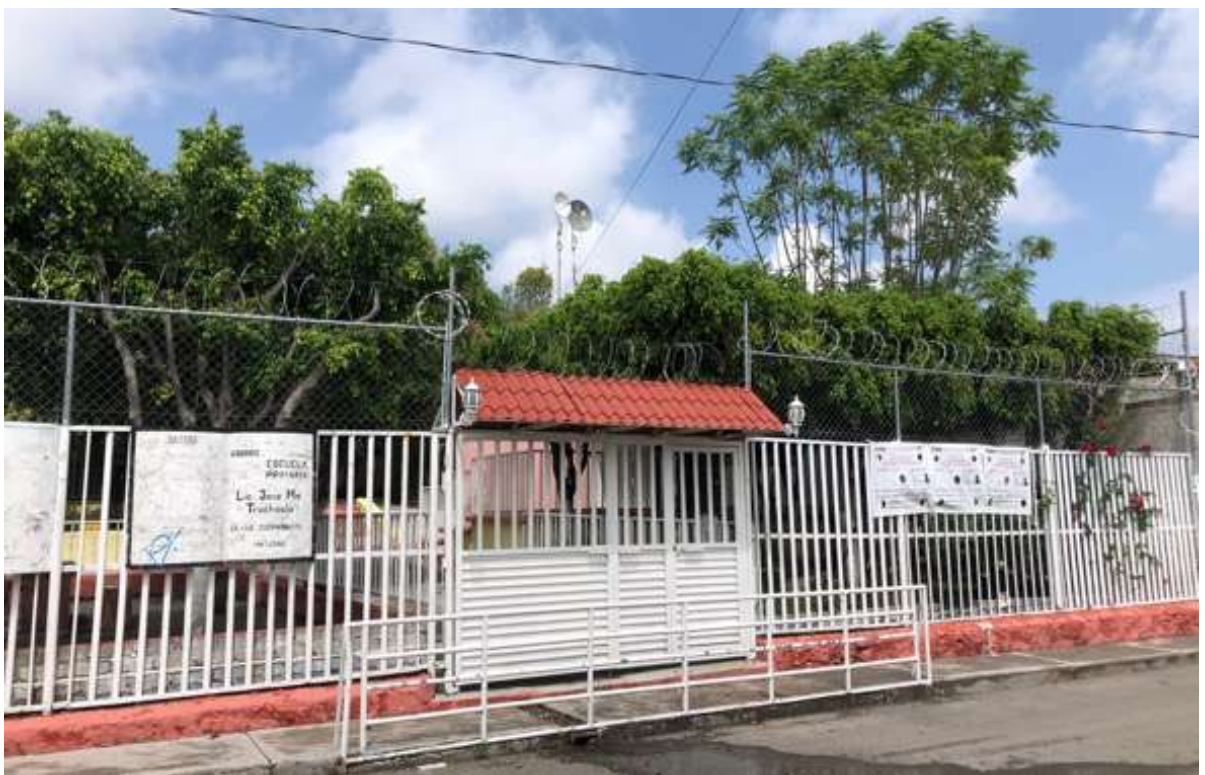
Figura 29. Fotografía tomada el 3 de junio de 2021 a la fachada de la escuela primaria Lic. José Ma. Truchuelo.
