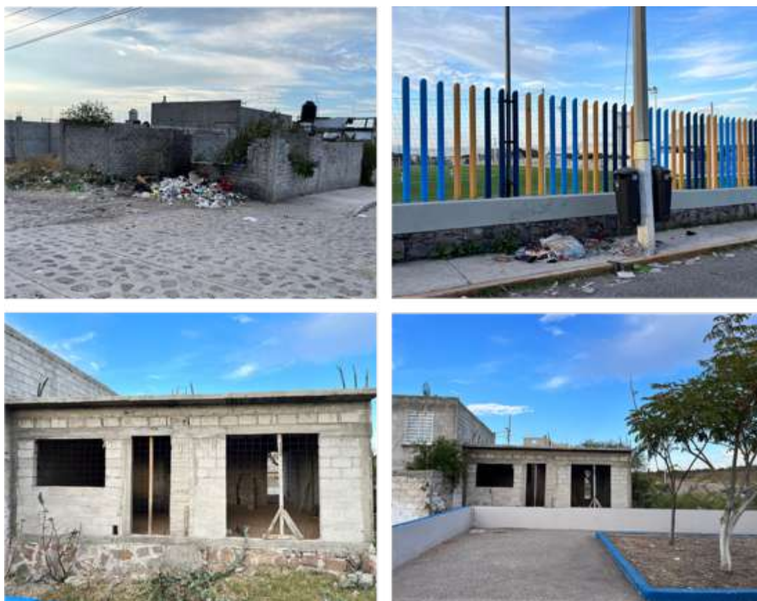
Figura 21. Fotografías tomadas el 26 de noviembre de 2022 con las que se ejemplifica algunos elementos que dañan la imagen de los espacios públicos de la delegación. La fotografía de la esquina superior izquierda fue tomada en una calle de la colonia Valle Arboledas, mientras que la de lado derecho fue tomada al exterior de la unidad deportiva de La Negreta, en la colonia Luis Donald Colosio. En ambos casos se observa basura regada en vía pública. Por su parte, las fotografías de la parte inferior fueron tomadas en lo que queda del parque de la colonia Valle de los Pinos, ahí puede verse que los contornos de este espacio público están enmarcados por obras incompletas y abandonadas, en donde es frecuente que ingresen personas sin hogar y vándalos para dormir o para hacer uso inapropiado de estas construcciones. Esta problemática disuade a jóvenes y a familias de hacer uso de los espacios mencionados.
