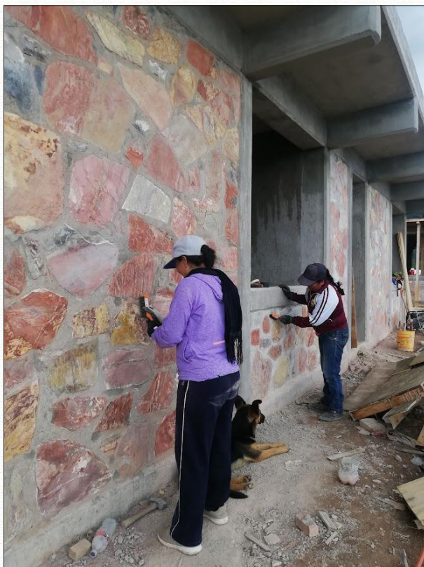
FIGURA 18. MUJERES PARTICIPANDO EN LA CONSTRUCCIÓN DE LA ESCUELA 23
