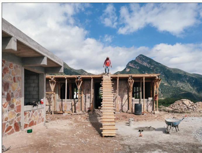
FIGURA 11. CIAC DURANTE SU CONSTRUCCIÓN 16
