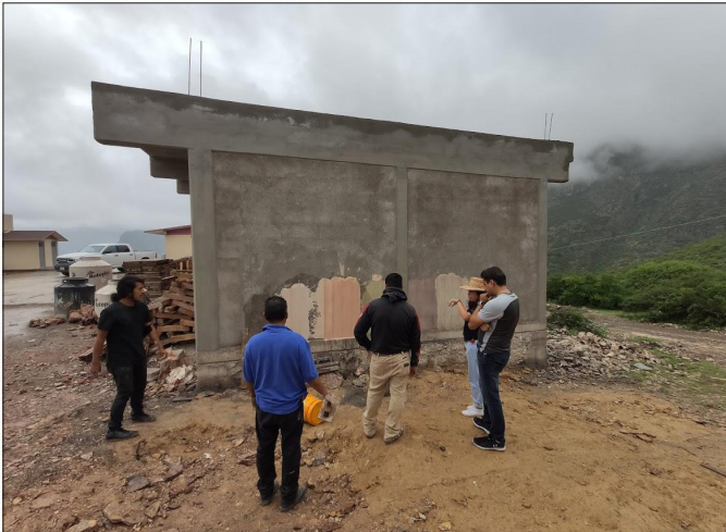
FIGURA 19. PRUEBA DE ACABADOS DURANTE LA OBRA 24
