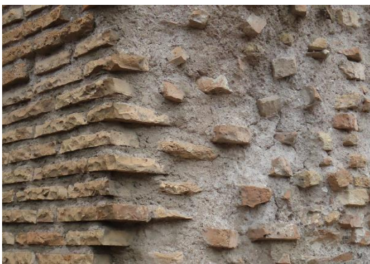
Ilustración 38: Ejemplo del concreto romano en los muros de sus edificaciones. Fuente archdaily.com
