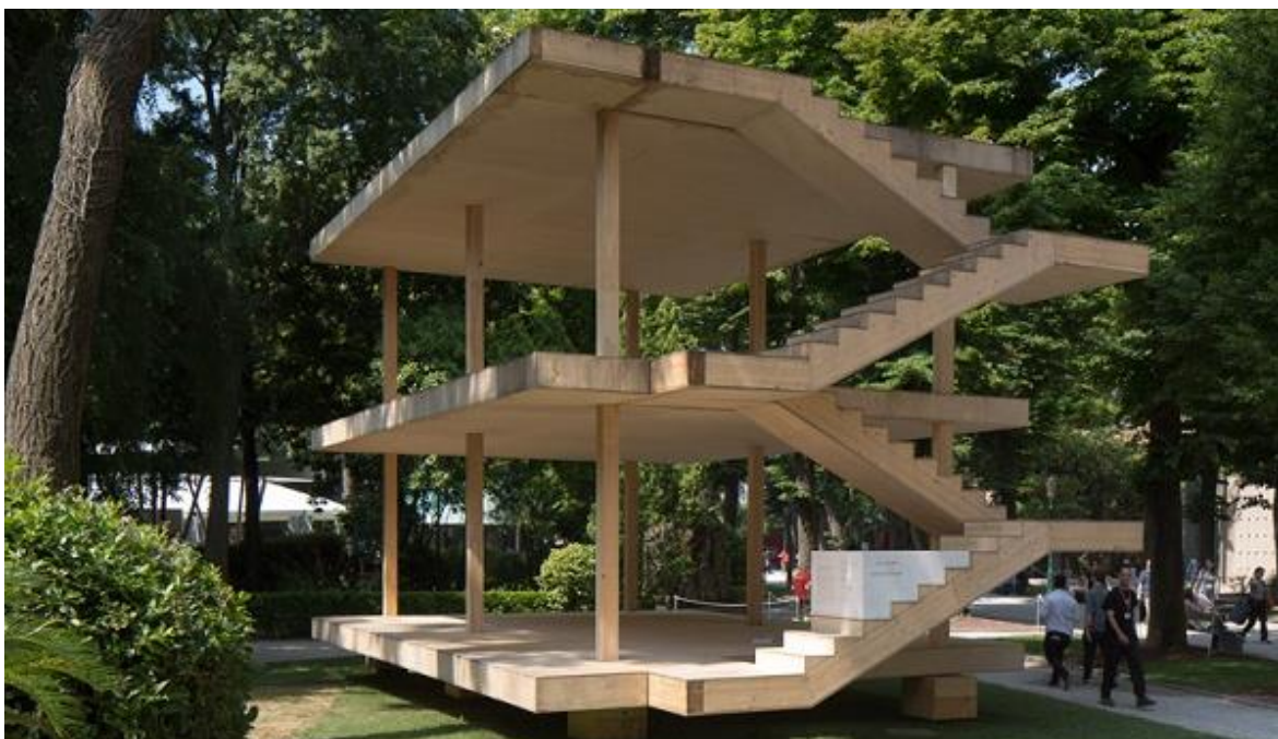
Ilustración 63: Sistema constructivo Do-mino, caracterizada por su sistema prefabricado y estandarizado en serie.(Gardinetti, 2019)
