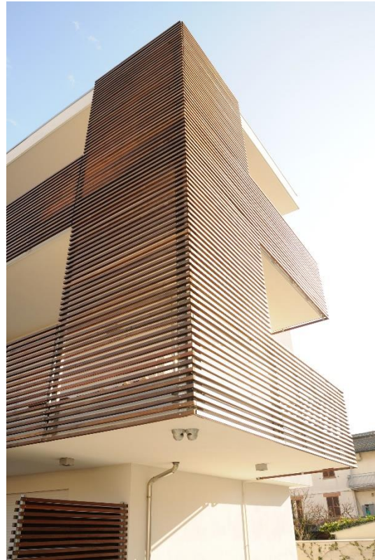
Ilustración 66: Sistema de control solar llamado brise-soleil, fue uno de los aciertos dentro de la arquitectura bioclimática moderna que permitía el control solar.
