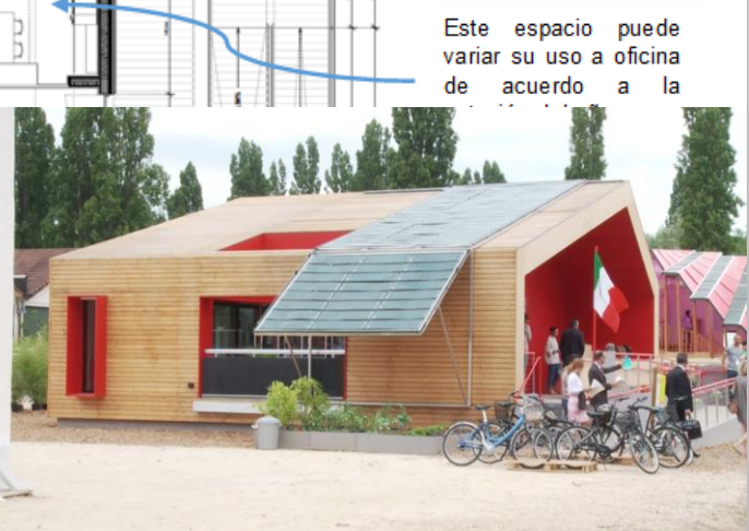
Figura 6: Logia de la fachada Sur-Oeste, con el SCS de paneles Fotovoltaicos [9]
