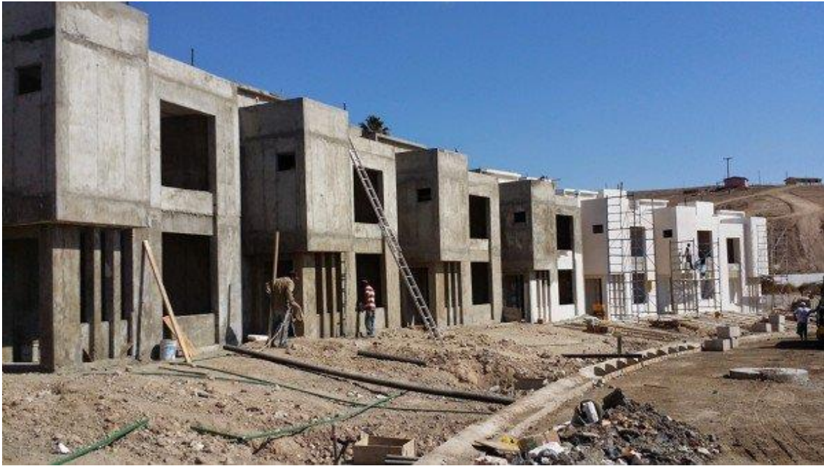
Ilustración 78: Construcción de obra negra de casas en serie, (habitissimo, 2019).
