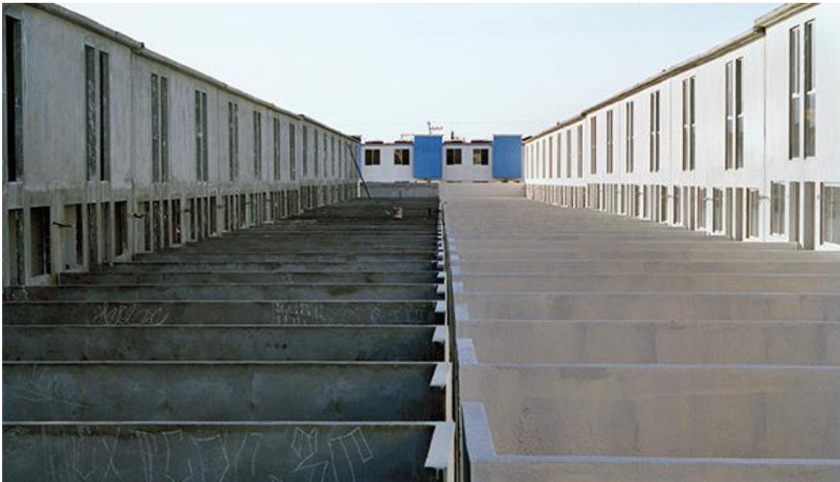
Ilustración 79: Patios traseros de casas en serie en obra negra. (Cabecera, 2019)
