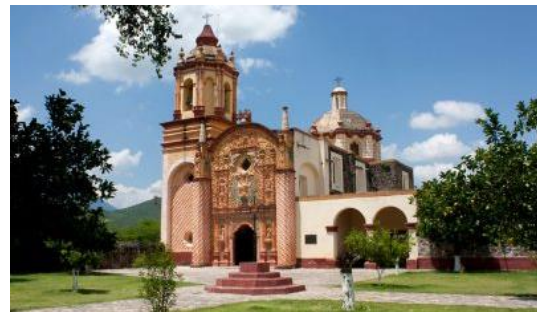
Ilustración 52: Misión Conca, Querétaro. Utilizaban elementos como arcos de medio punto y pórticos en las iglesias, llamadas capillas pozas, dónde se mantenían a los indígenas antes de ser cambiados al cristianismo. (De-Paseo, 2019)
