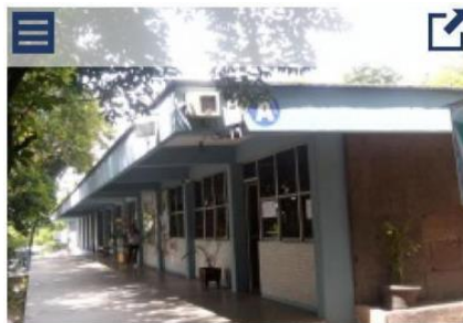
Figura 52. Ejemplo de fotografía de la fachada del edificio “A” de la Facultad de Ingeniería UAQ.
