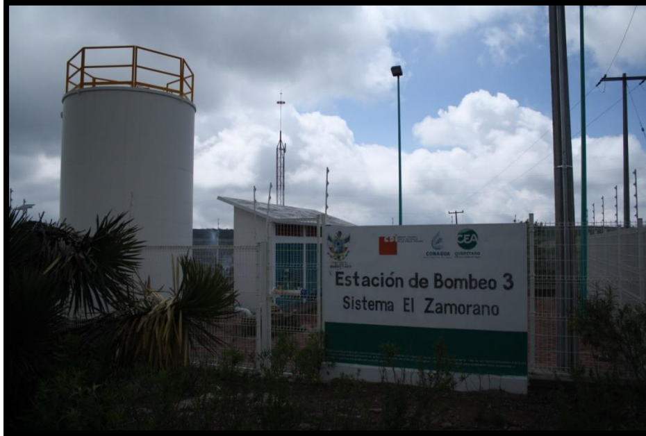
Fotografía 6. Estación de bombeo El Zamorano III. Nuevo Álamos, 30 de abril del 2015.
