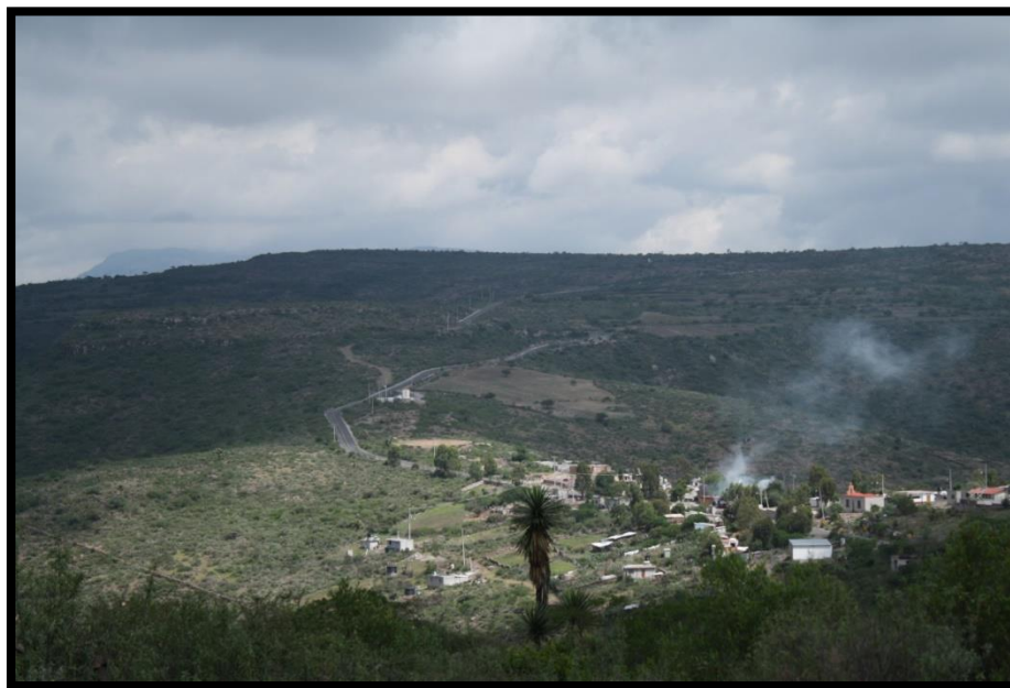
Fotografía 12. Vista panorámica de la localidad de Nuevo Álamos. Nuevo Álamos, 30 de abril del 2015.
