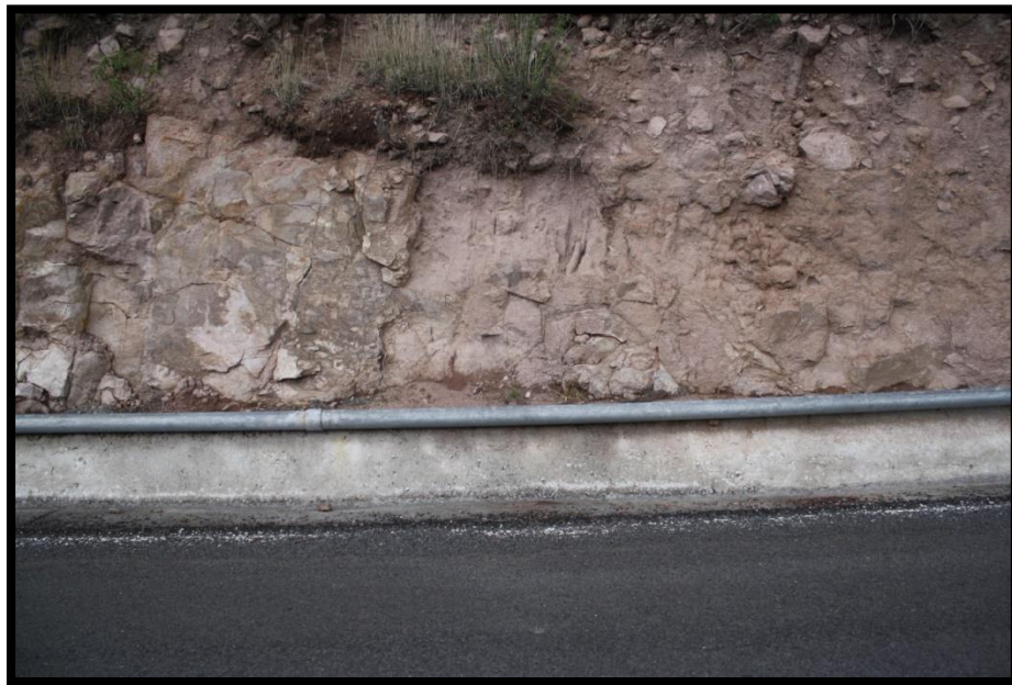
Fotografía 13. Tramo de la tubería que lleva el agua de la parte baja a la parte alta de la cuenca. Nuevo Álamos, 30 de abril del 2015.
