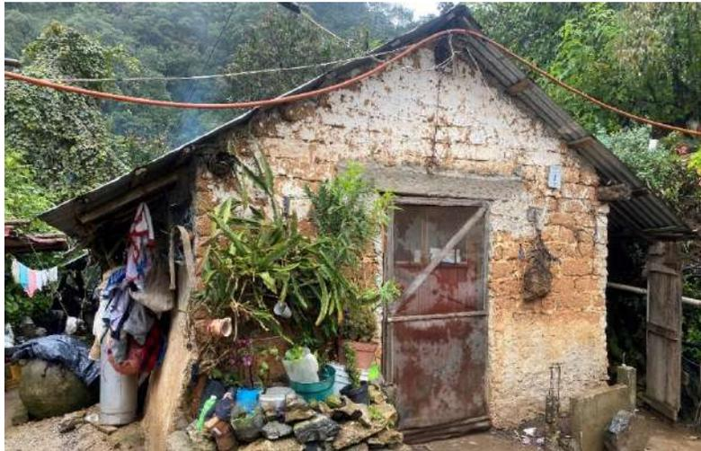
El resultado de esto, son bloques de gran formato, que se utilizan para dar forma a los muros de las viviendas y otro tipo de construcciones, uniéndose con una mezcla de la misma arcilla de barro, agua y cal.
