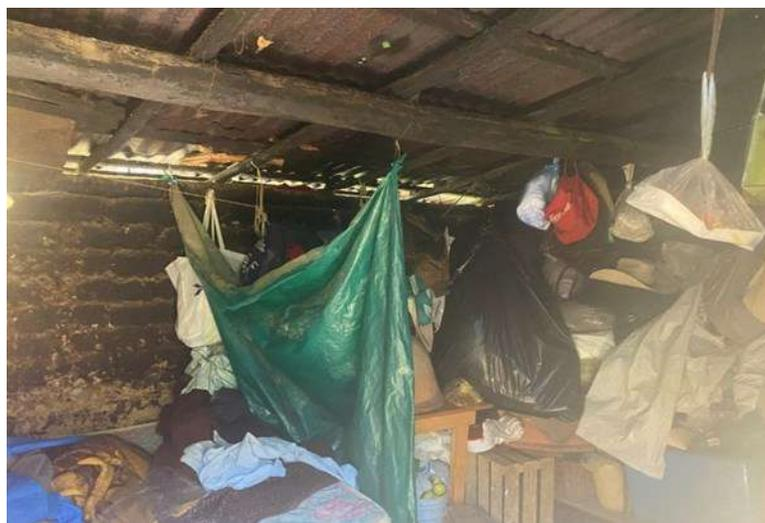
Algo similar ocurre con el material utilizado para formar los techos, que presenta perforaciones resultantes del mal estado de las chapas de acero galvanizado o cartón asfaltado utilizadas para fijarse a la estructura de madera de pino sin procesar ni tratar. En cuanto a las paredes, se observa que la madera utilizada está emparejada sin lograr un sellado hermético, y se utilizan clavos y alambres para anclarlas a la estructura de madera de troncos de pino, como se muestra en la figura 38.
