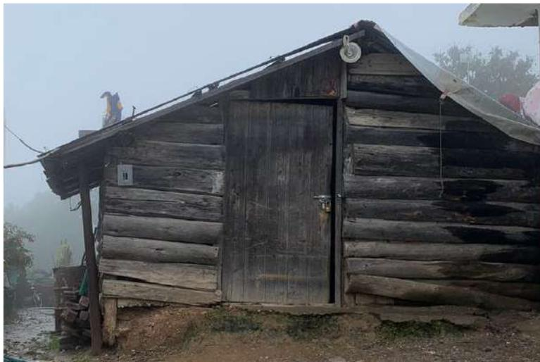
Por este motivo, las viviendas suelen tener techos inclinados, utilizando tejas de barro rojo recocido o láminas metálicas en algunos casos, para evitar que la nieve y el agua se acumulen en el techo.
