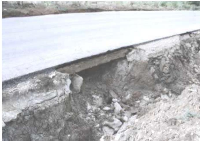
**Figura 2. 10 Capa estabilizada con cal soporta la erosión.**
