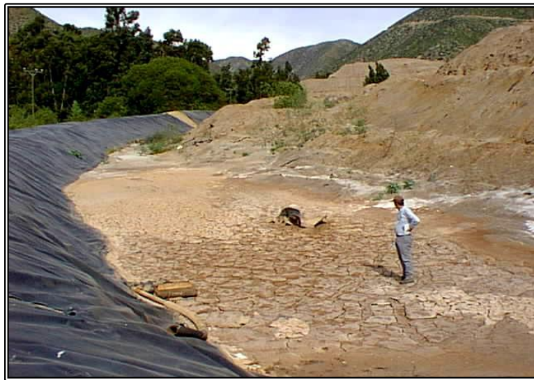
Figura II- 12 Impermeabilizado basal de escombrera Punitaqui (Chile) (ITGE, 1995)
