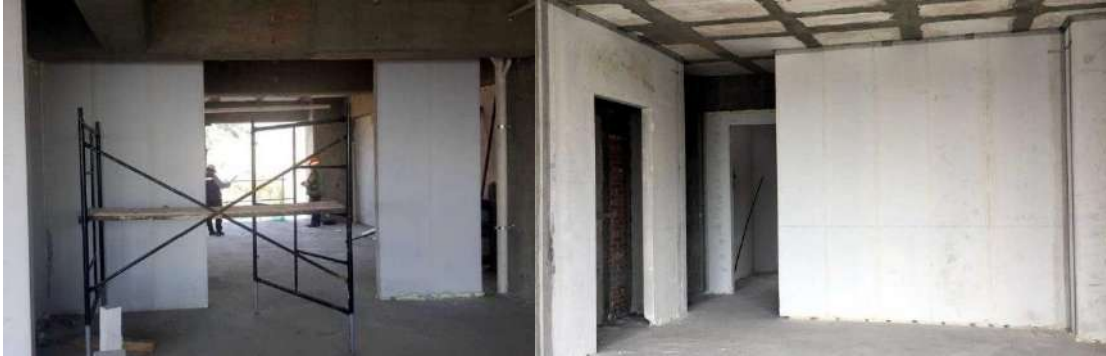
Figura 2 Muros divisorios de concreto (LBS, 2022).
