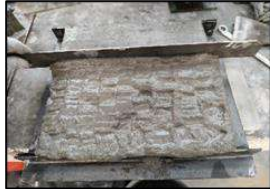
Figura 85 Eliminación de excedentes con regla.
