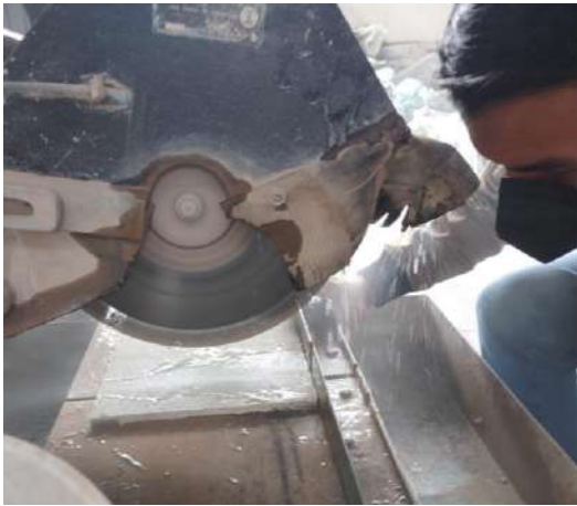
Figura 102 Corte de placas con sierra de concreto.
