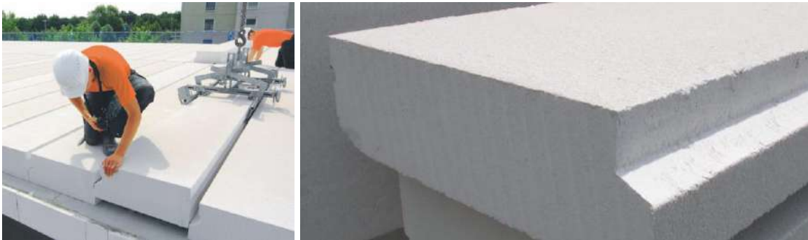
Figura 3 Sistema de panel constructivo para para losa de mampostería (Hebel, 2022).
