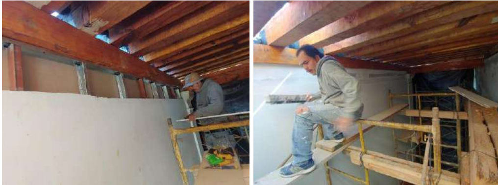
Figura 6 Aplicación de panel de yeso.
