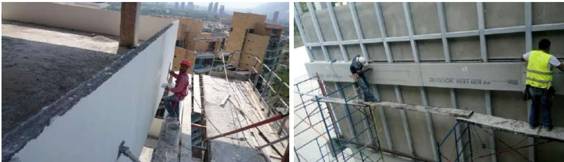
Figura 5 Colocación de paneles de concreto para faldones (Grupo FRERES, 2020).
