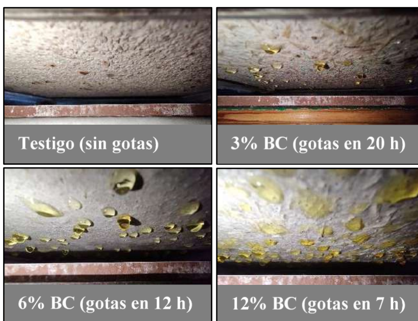
Figura 139 Reporte fotográfico de la inspección visual de los cuatro grupos de análisis en la prueba de permeabilidad.
