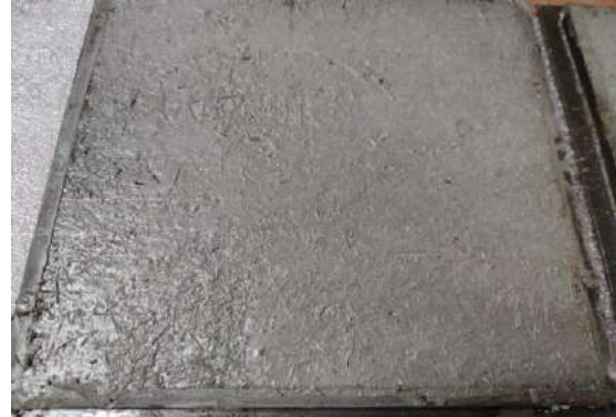
Figura 87 Panel terminado fraguando.
