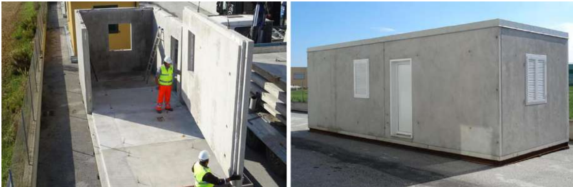
Figura 1 Construcción de módulos habitables (EMMEDUE, 2022).
