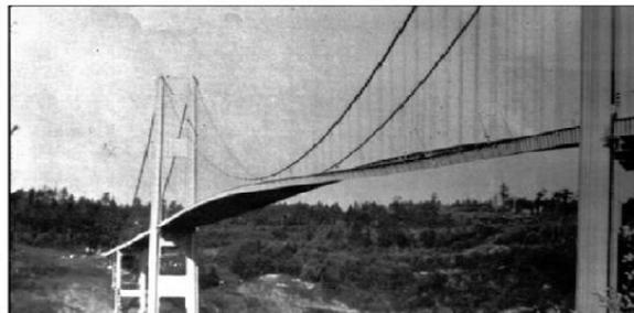
Figura 1-2. Puente Tacoma Narrows oscilando torsionalmente antes de colapsar (Arioli and Gazzola, 2015)
