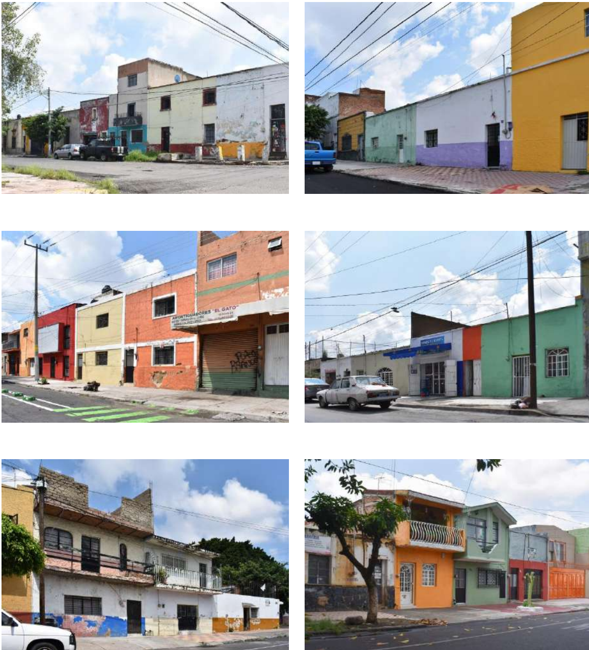
Figura 42 Niveles de edificación actual de la zona de estudio
