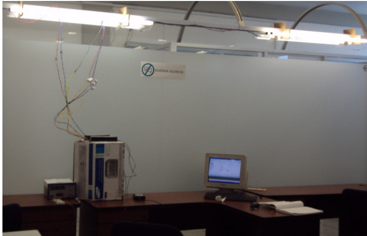
Figura 10. Implementación física del sistema.
