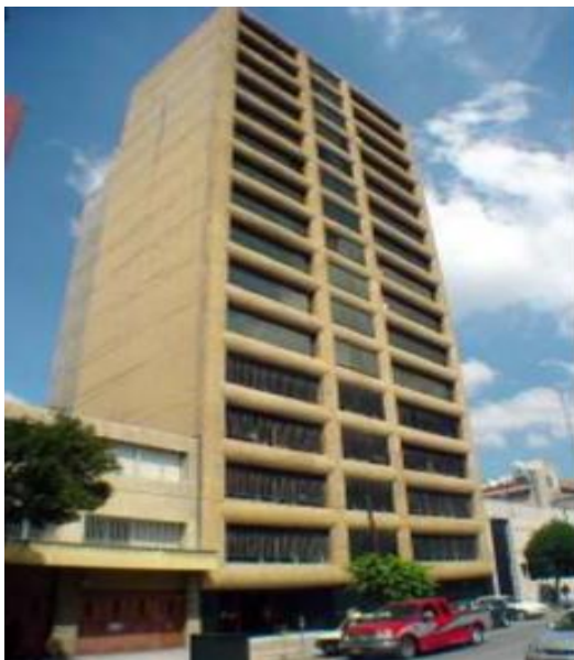
Fig. 3 Edificio 16 niveles, 412 m 2 y 5,679 ton. (Santoyo, 2005)
