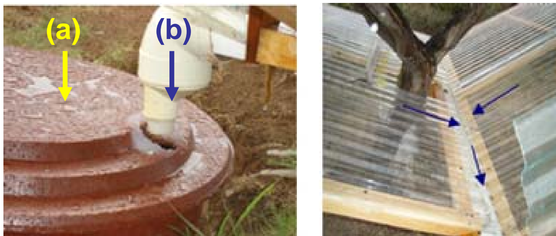
Figura 8. Recipiente de almacenamiento (a) de la lluvia captada por láminas de policarbonato(b) con pendientes para dirigir el flujo hacia una canaleta de PVC (derecha).
