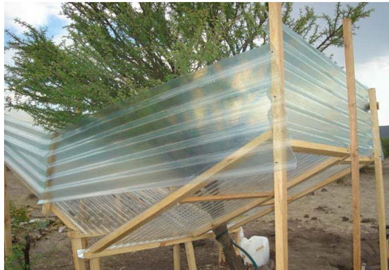
Figura 9. Estructura de madera donde se aprecian las láminas verticales para evitar entradas laterales y las horizontales para la captación de la precipitación neta.
