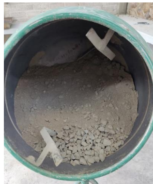
Figura 30. Revolvedora con 50 % del total de grava, 50 % del total de arena, 50% del total del cemento mezclado durante unos 30 segundos.
