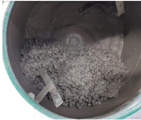
Figura 31. Revolvedora con todos los materiales (grava, arena, cemento, agua y fibras de algodón).
