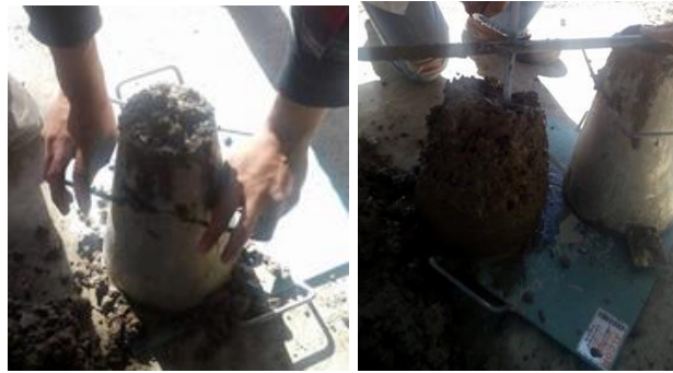
Figura 33. Medición del revenimiento.
