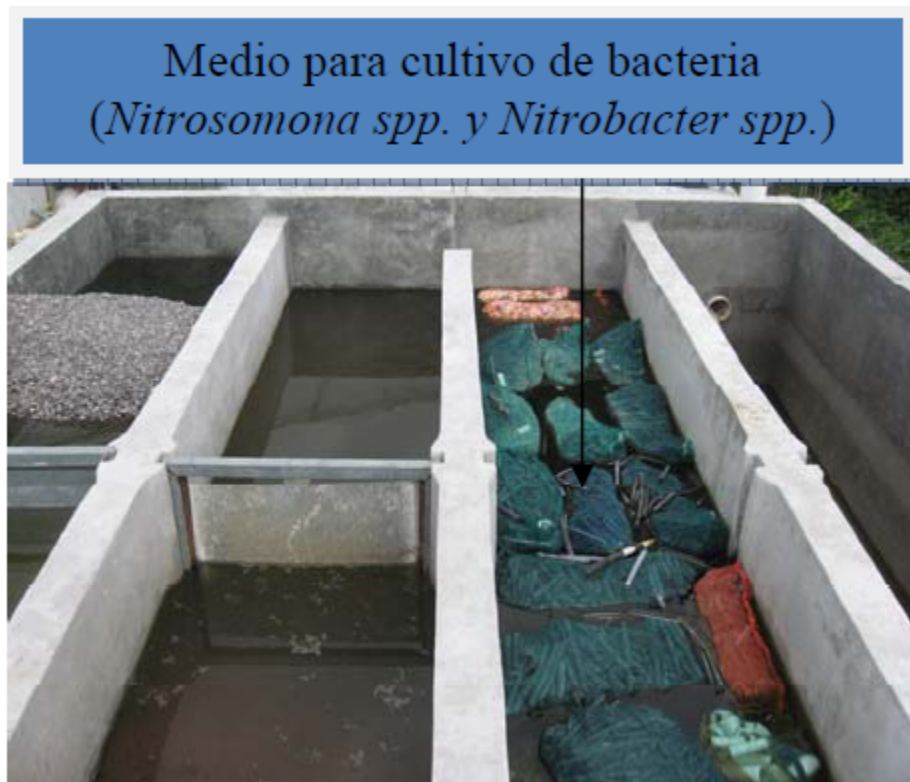
Figura 3.5 Etapa de biofiltro en el sistema de recirculación de agua
