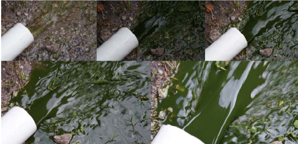
Figura 3.3 Drenado de sedimentos por gravedad en el sistema de recirculación
