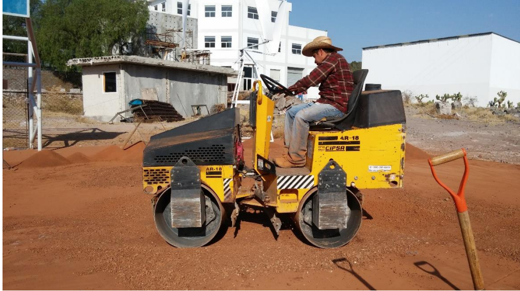
Figura 4.40 Rodillo compactador para disgregado de material
