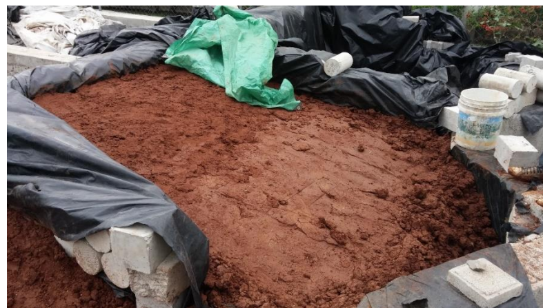
Figura 4.47 Conformación de talud de pendiente constante
