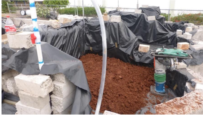
Figura 4.45 Colocación de capas de suelo en las parcelas
