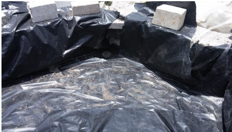
Figura 4.24 Coladera para recolección de agua infiltrada
