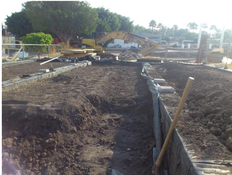
Figura 4.22 División por muros de tabicón
