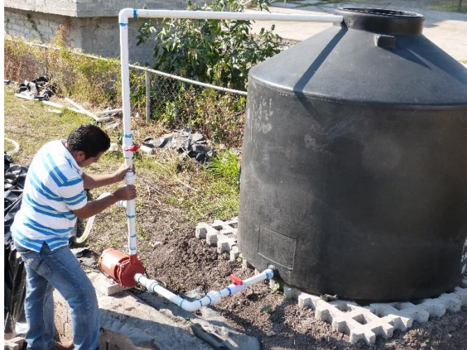
Figura 4.27 Instalación del sistema hidráulico
