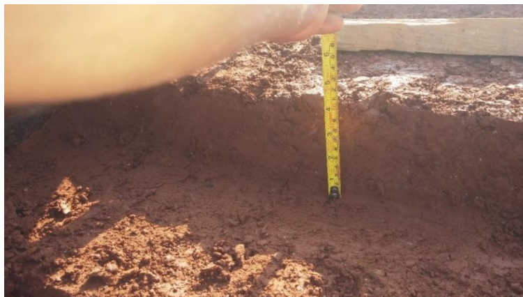
Figura 4.49 Dimensionamiento de los escalones
