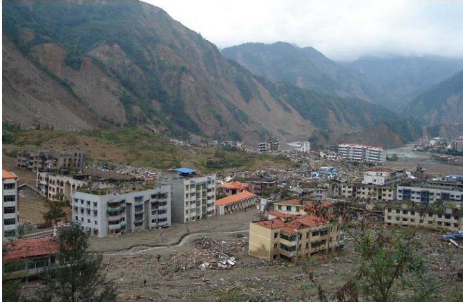
Figura 2.31 Vista panorámica de la destrucción de viviendas y de los deslizamientos inducidos tras la ocurrencia de un terremoto.
