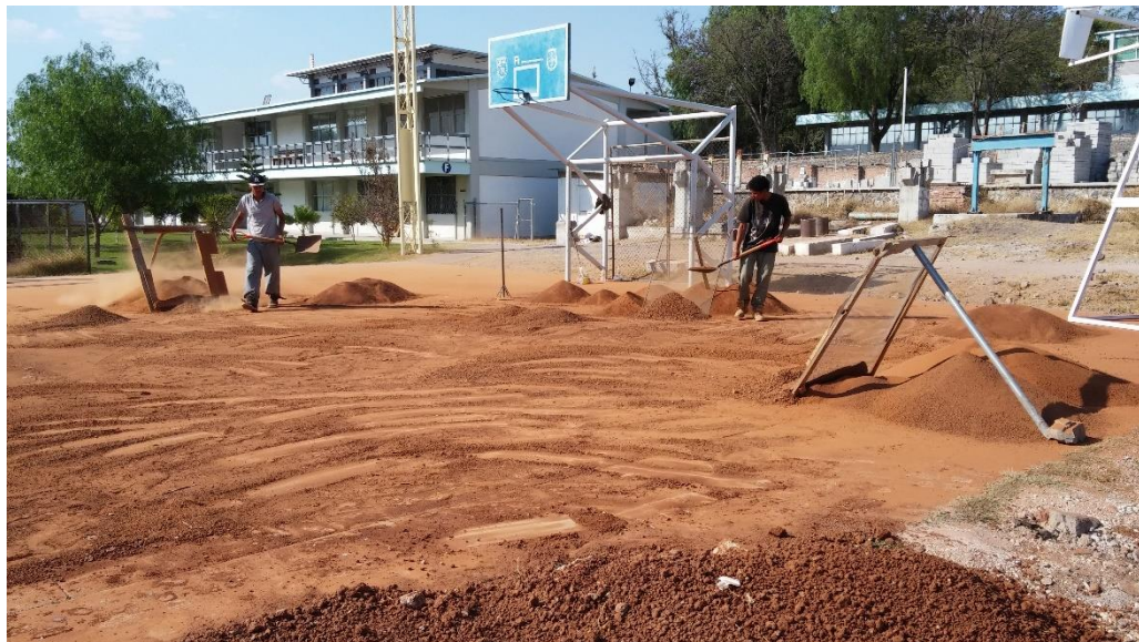
Figura 4.39 Cribado de material mediante malla #40
