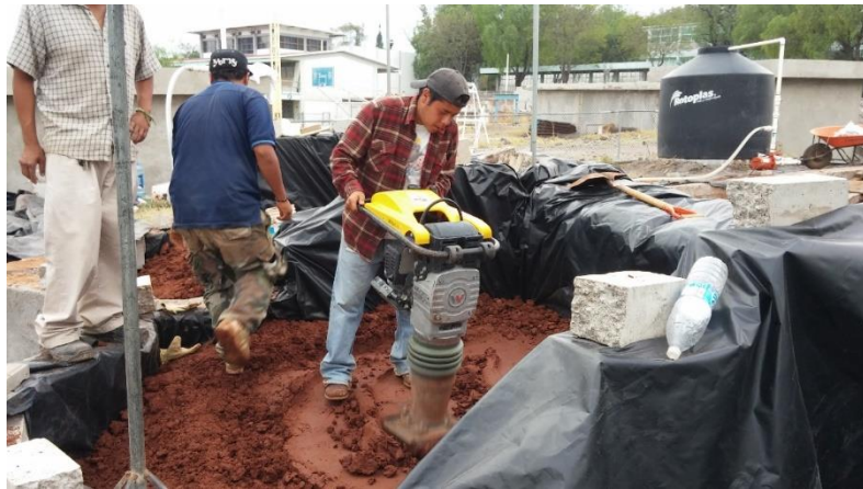
Figura 4.46 Compactación de suelo
