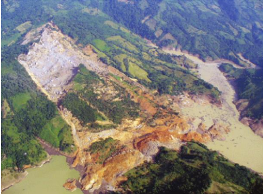
Figura 2.30 Fotografía aérea del deslizamiento de talud
