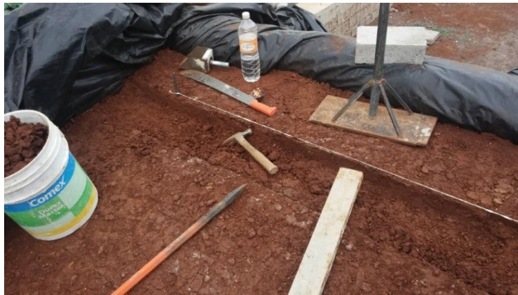
Figura 4.48 Labrado de escalón en el talud
