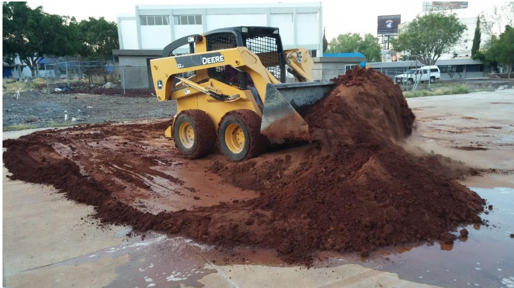
Figura 4.43 Empleo de minicargador para homogenizar el material
