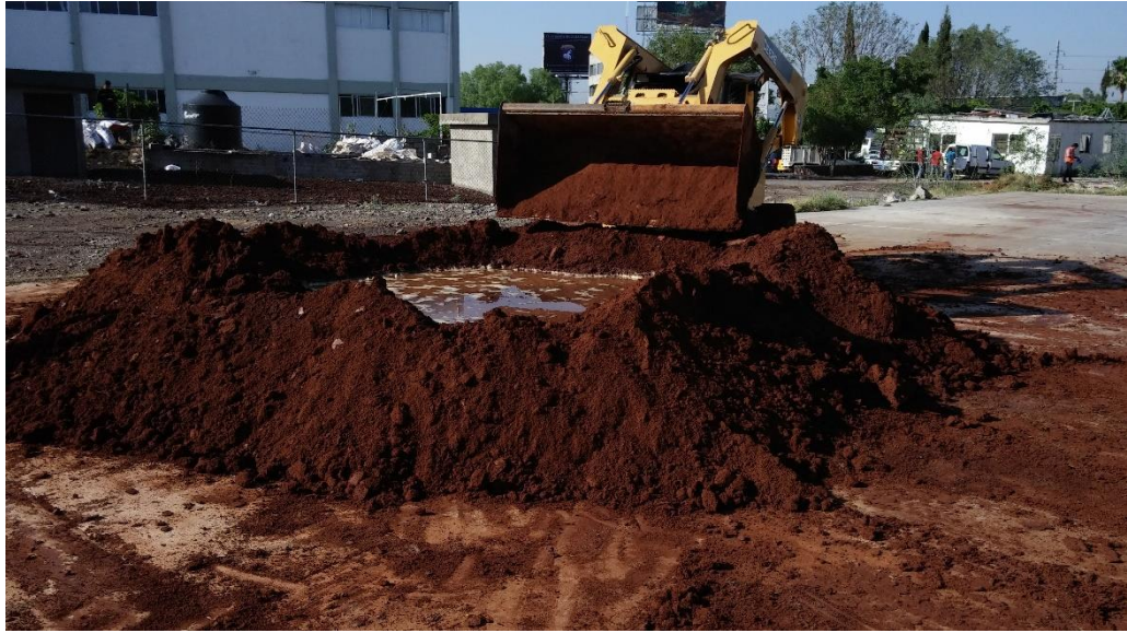
Figura 4.42 Adición de agua al suelo
