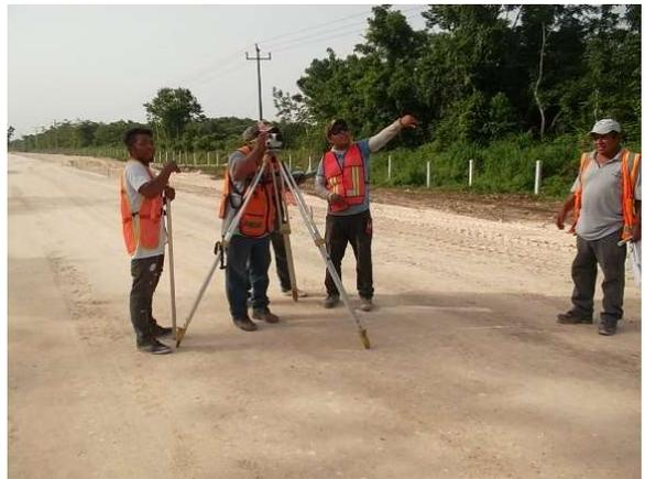
**Figura 7. Equipo de topografía con nivel topográfico.**
