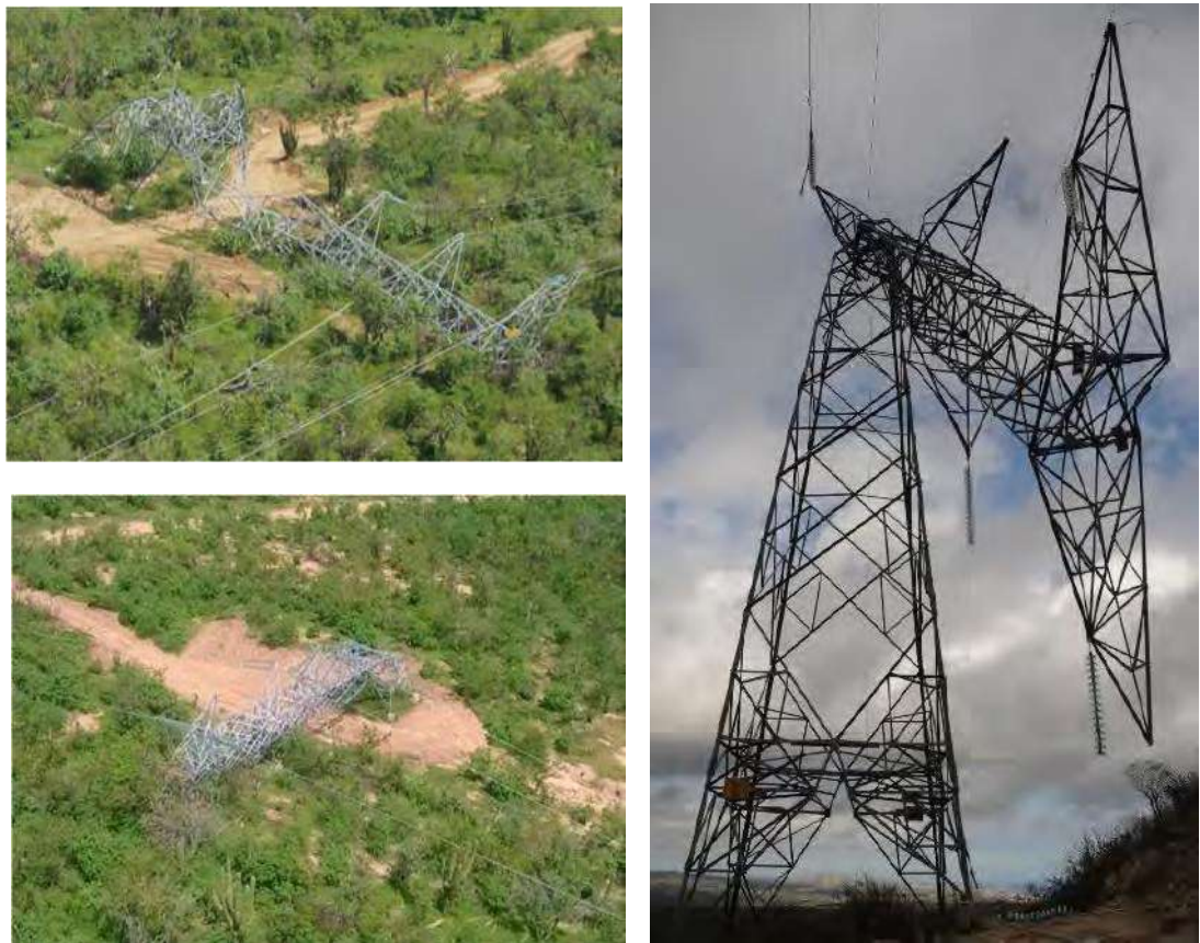
Figura 1.2 Fallas en las líneas de transmisión por el paso del huracán Odile (Murià Vila et al., 2015)
