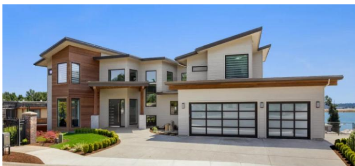
Figura 3.6 Vivienda residencial plus. Fuente: ION (2019).
