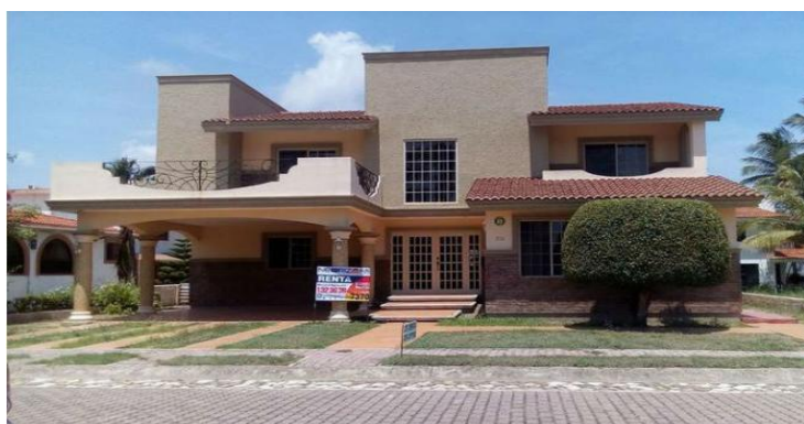
Figura 3.5 Vivienda residencial. Fuente: Hernández (2020).
