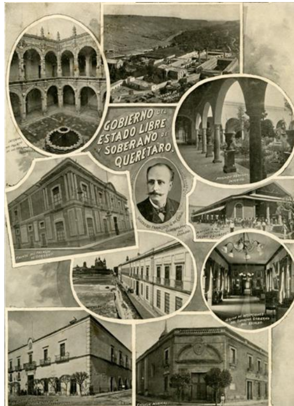
Imagen 13, Ing. Francisco González de Cosío gobernador de Querétaro, y vistas del Estado
