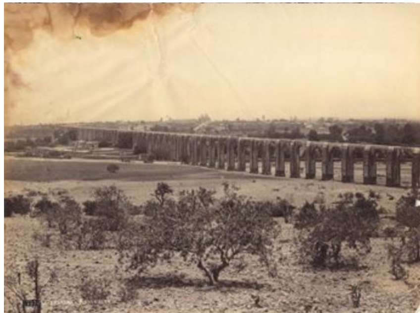
Imagen 14, “Querétaro y el acueducto”
