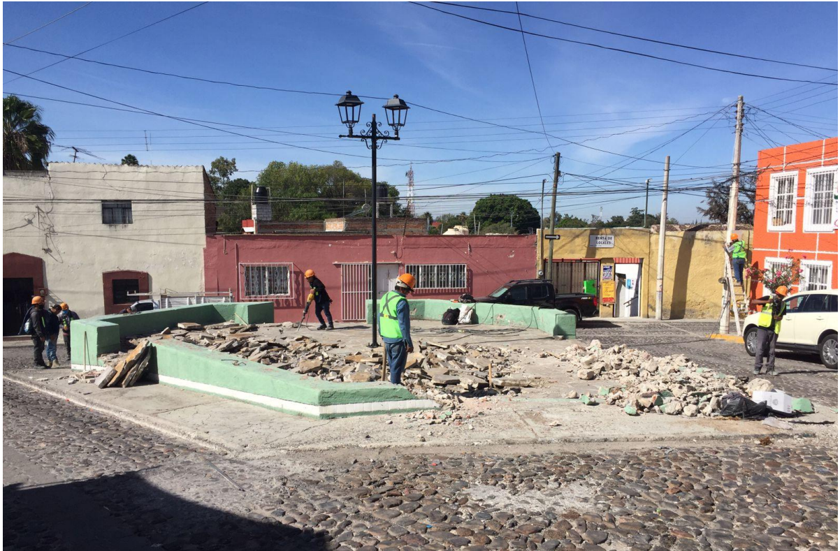
Figura 3.23 Foto de demolición de la antigua Plazuela Pipila. Tomada por: Dr. Emiliano Duering.
