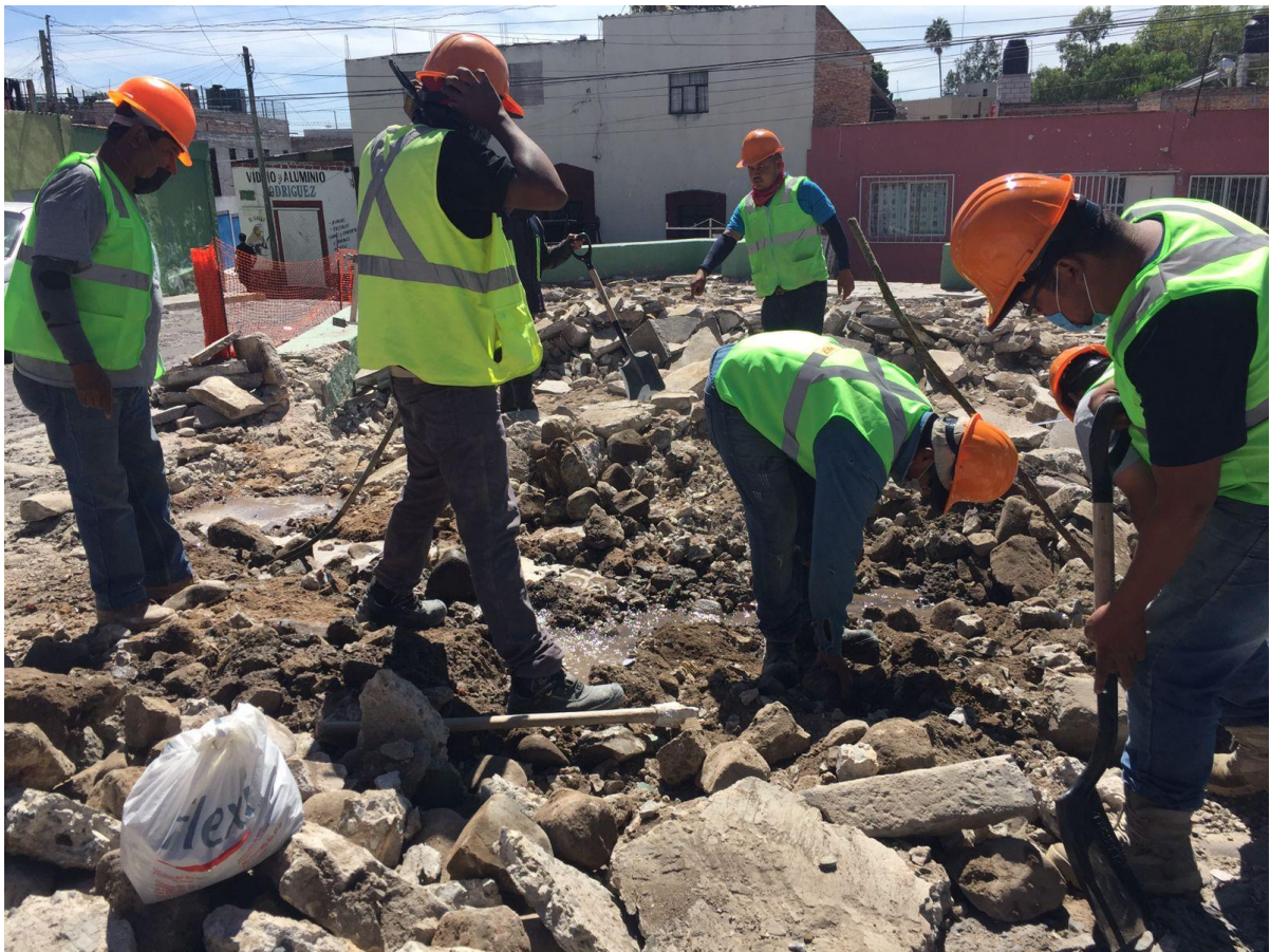
Figura 3.24 Foto de demolición de la antigua Plazuela Pipila tomada por el Dr. Emiliano Duering.
