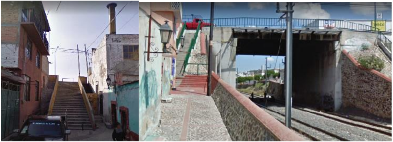
Figura 5.5 y 5.6 Escaleras de Av. Corregidora Calle Tepe. De Google Earth.
