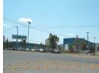
Parque Industrial Balvanera
