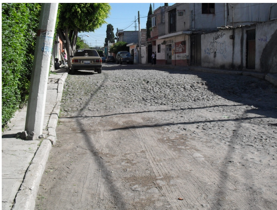
Figura 4.2.1 Diferencial Vertical en la parte Sur de la Falla 5 de Febrero.
