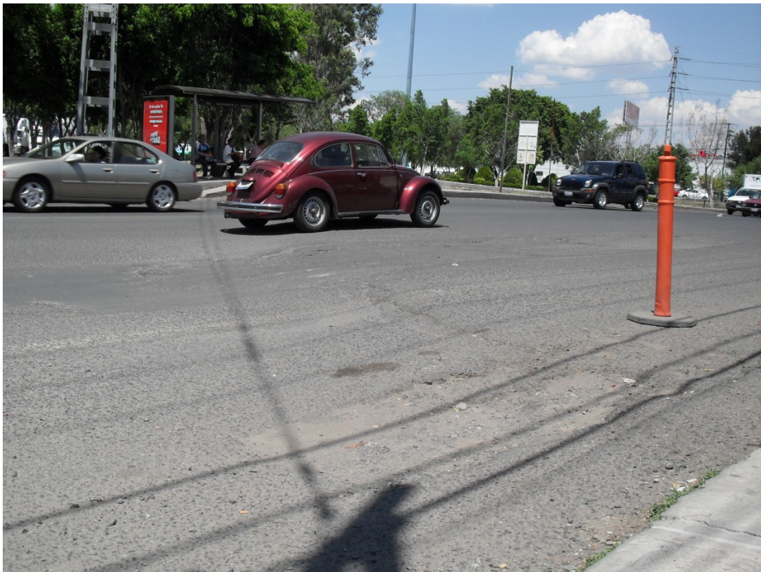
Figura 7.1 Foto del Diferencial vertical en la Av. Universidad.
