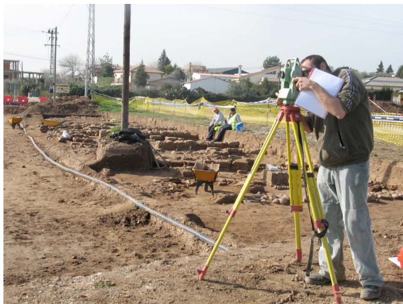
Figura 4.1 Se muestra la utilización de la Estación total y GPS.
