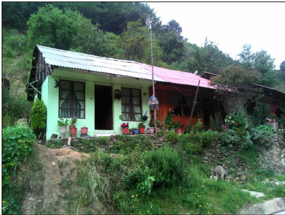
Figura 53. Vivienda construida de madera, Localidad de Dolores, municipio de Angangueo.
