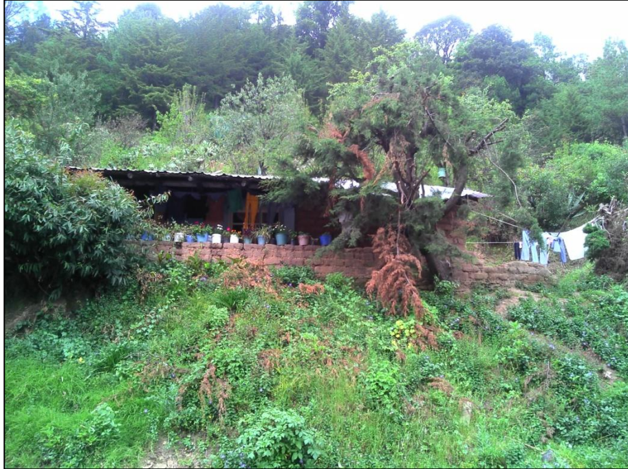
Figura 54. Vivienda construida de adobe, Localidad de Dolores, municipio de Anganguero.
