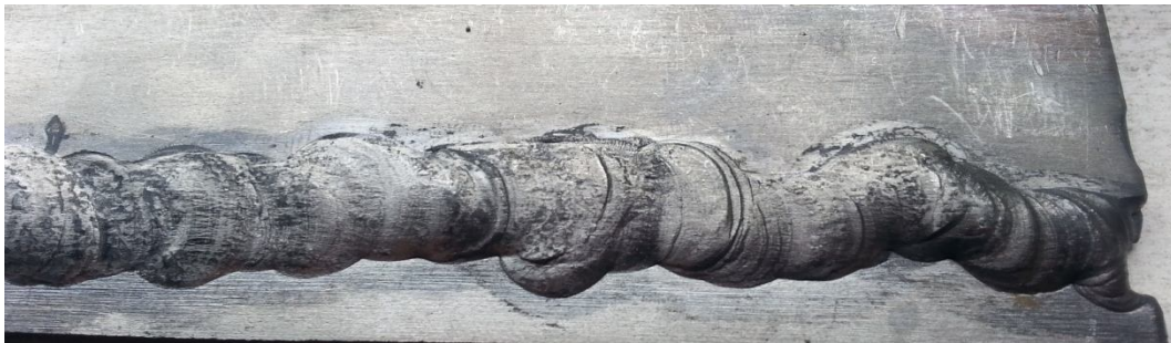
Figura 5.8 aplicación semiautomática de soldadura
