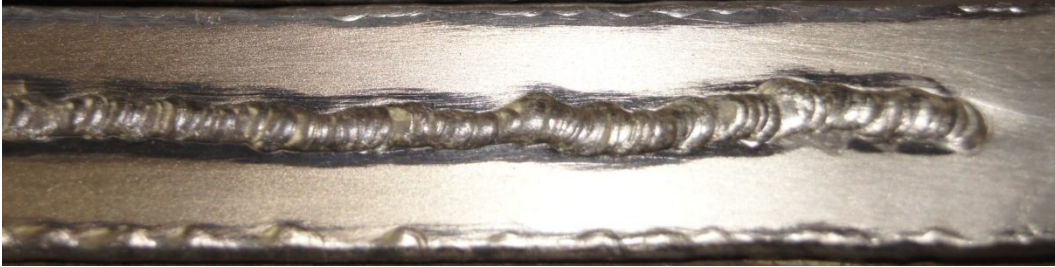
Figura 5.2 aplicación manual de soldadura
