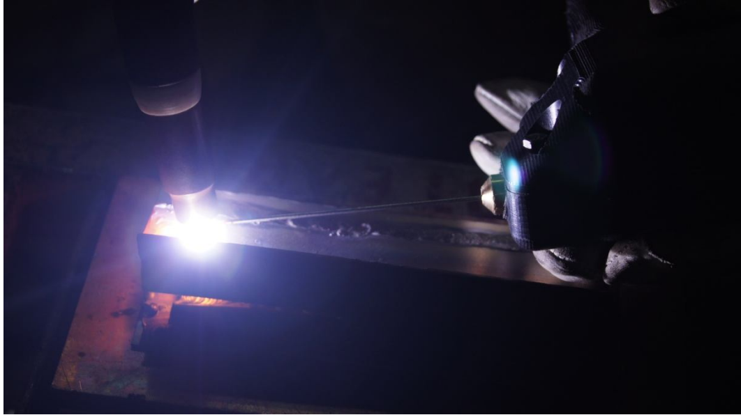
Figura 5.5 aplicación semiautomática de soldadura
