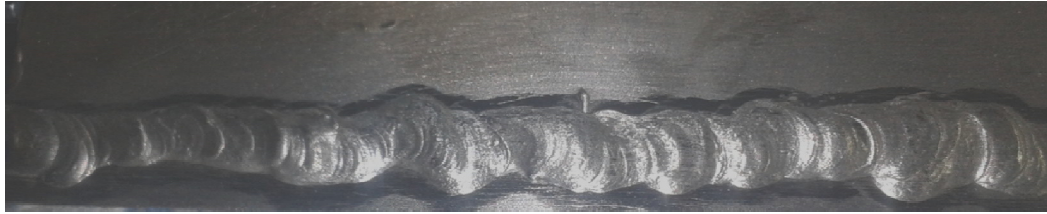
Figura 5.7 aplicación semiautomática de soldadura
