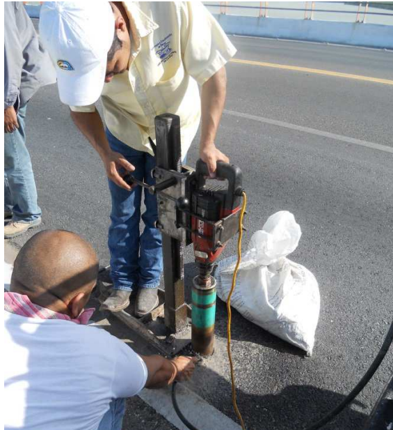
Figura 14. Extracción de núcleos de carpeta asfáltica.
