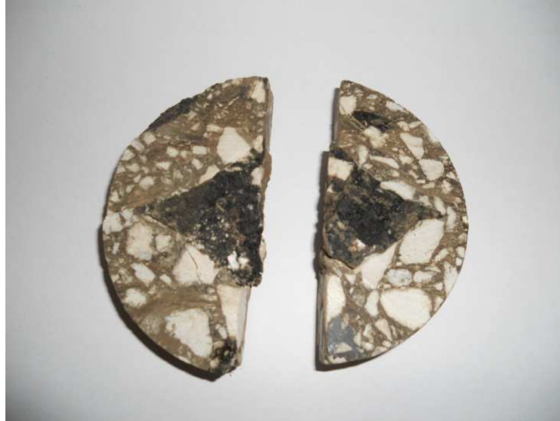
Figura 15. Seccionamiento de un núcleo de carpeta asfáltica.
