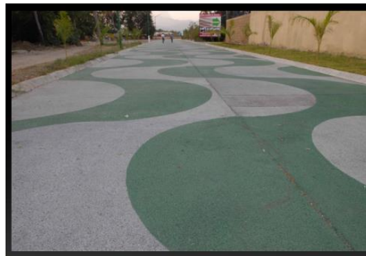
Figura 2.8 Calle pavimentada con concreto ecológico en Manzanillo, Colima, México.
