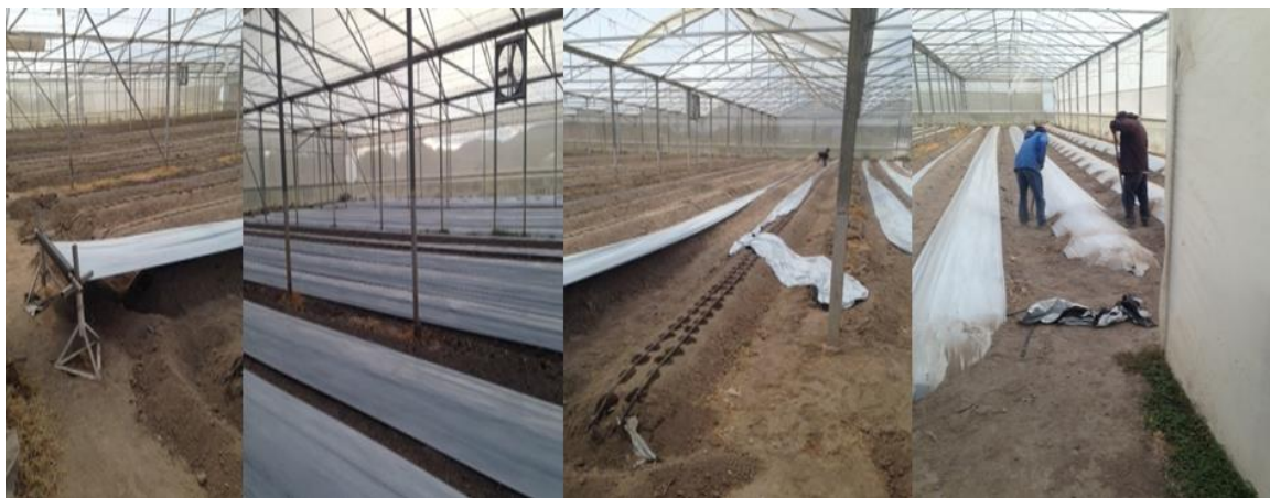
Figura 13.9.5 Colocación del acolchado
