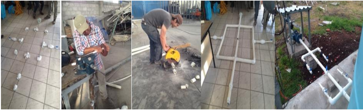
Figura 13.9.9 Procedimiento de armado del cabezal de riego
