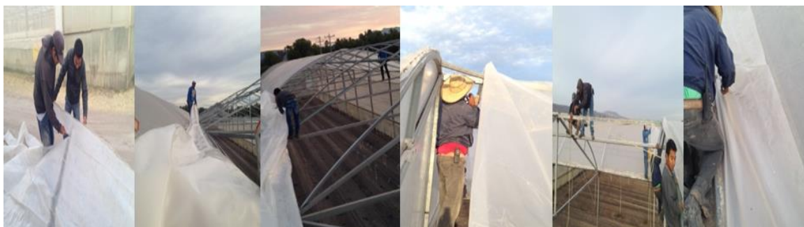
Figura 13.9.6 Colocación del plástico
