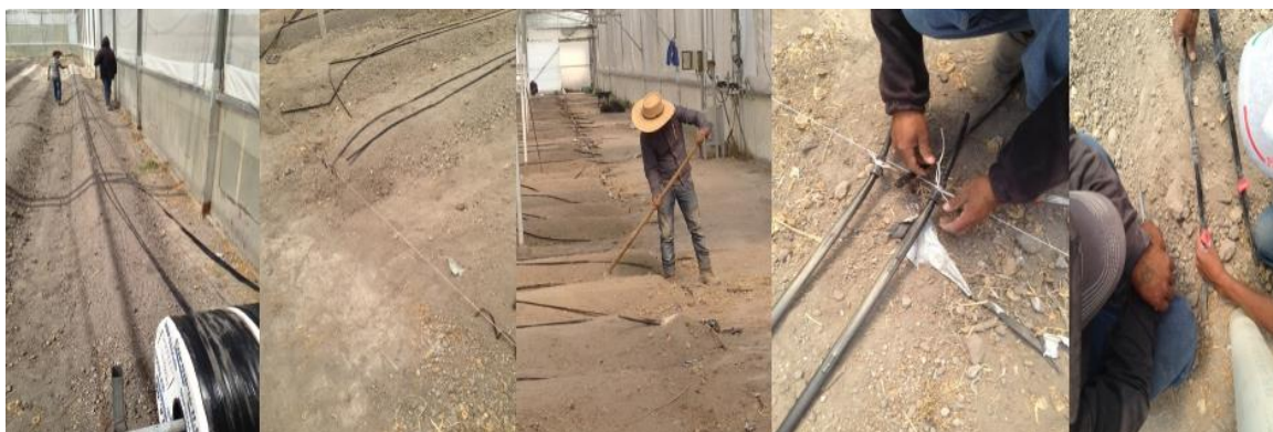
Figura 13.9.4 Colocación de cintilla y marcado de inicios de camas
