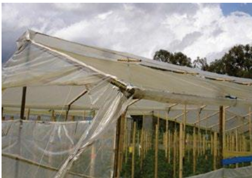
Figura 7.1.4 Acumulación de polvo sobre el plástico en un invernadero
