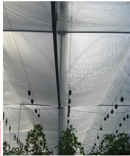
Goteras y Condensación
