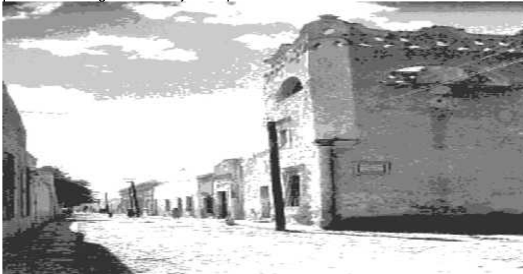
Figura 3. 2. Casa del Faldón sobre la calle Primavera en la que se aprecian los postes de energía eléctrica y el empedrado de las calles.
