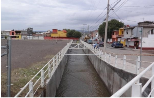
a) Canalización del Dren a la entrada de la cabecera delegacional.
