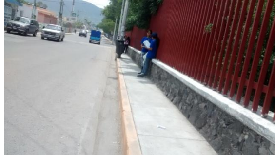
b) Cuneta en la banqueta del COBAQ
