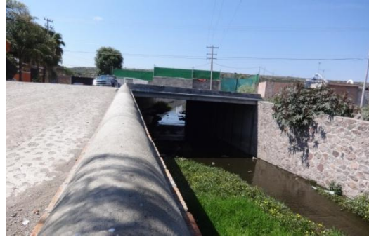
b) Canalización del Dren antes de llegar al Parque Bicentenario
