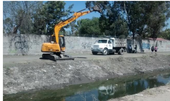
b) Labores de desazolve
