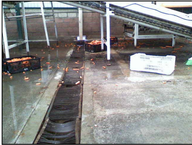
Figura 17. Coladera del área de empaque en mal estado; inadecuado manejo de la zanahoria. Empresa A.
