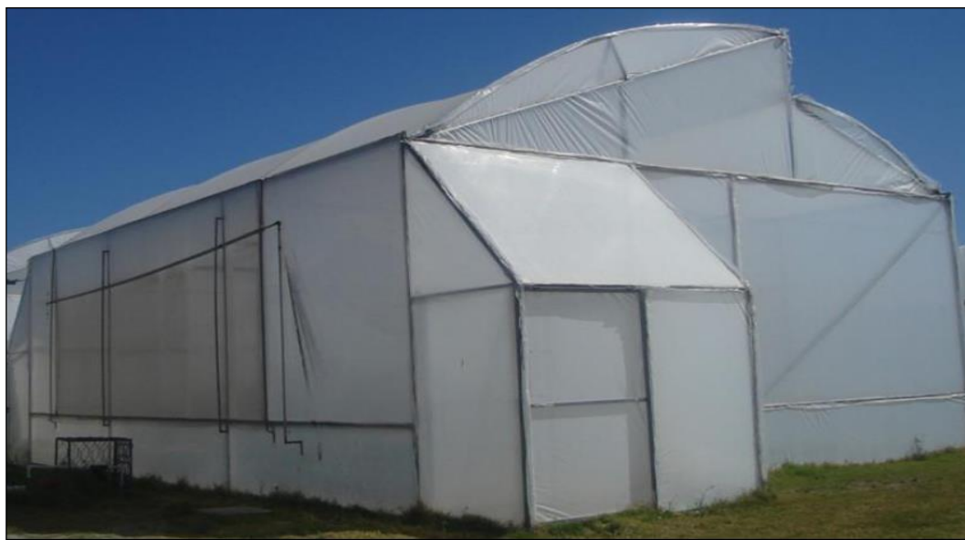
Figura 1. Invernadero utilizado. Invernadero tipo capilla a doble capa con cubierta plástica de polietileno, de 108 m 2 de extensión.
