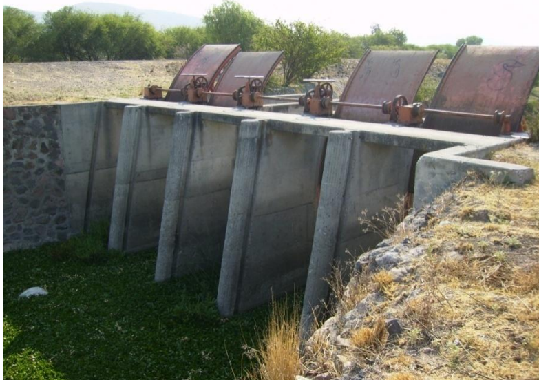
Figura 2.3. Canal de aguas negras conducido a la presa a manera de dique en época de lluvias.
