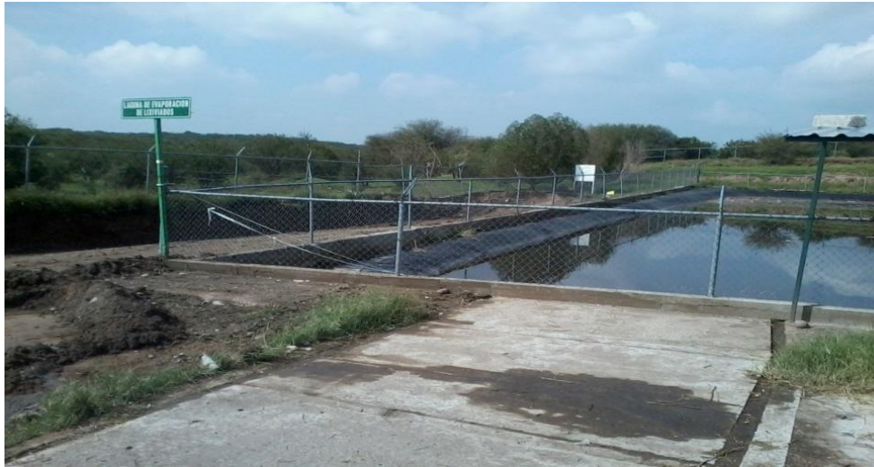
Ilustración 8. Piscina de Lixiviados del Relleno Sanitario Municipal.
