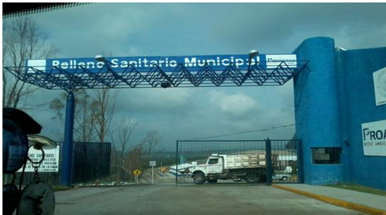
Ilustración 6. Entrada al Relleno Sanitario Municipal
