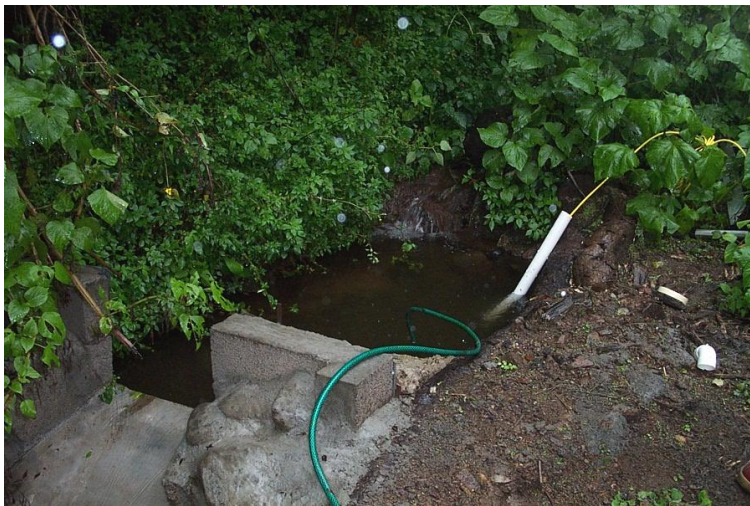
Figura 4.7. Vertedor construido en la salida de la AC experimental 18 (cálculo de dimensiones y construcción por el autor).
