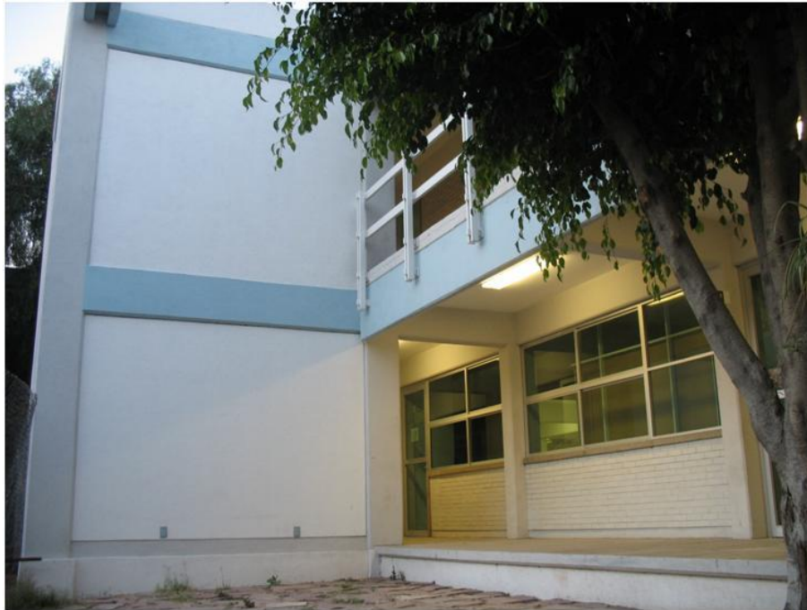
Figura 4.4 Centro de Cómputo Facultad de Ingeniería de la UAQ
