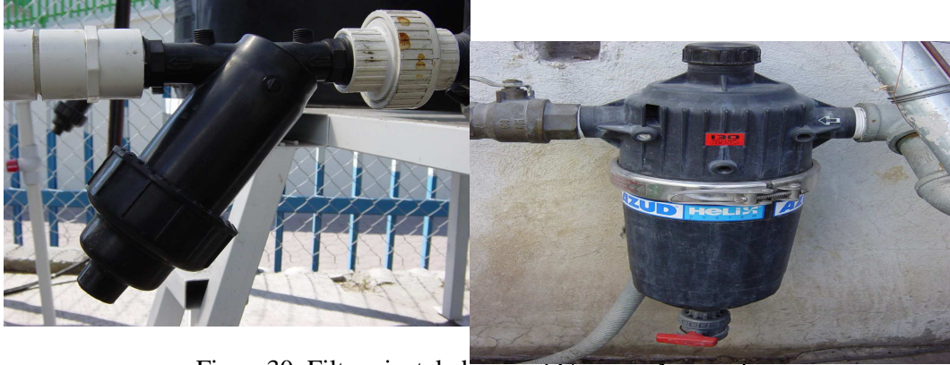
Figura30. Filtros instalados en el Campus Amazcala.
