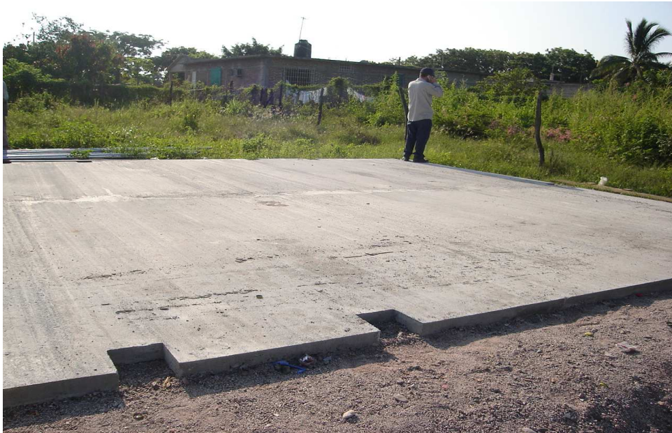
Figura 33. Construcción placa de concreto
