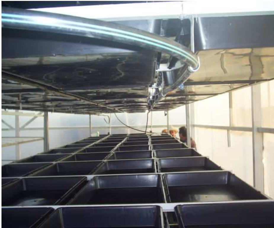
Figura 19. Red de distribución (mangueras)
