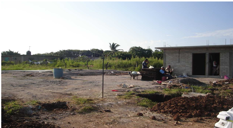
Figura 32. Adecuación del terreno
