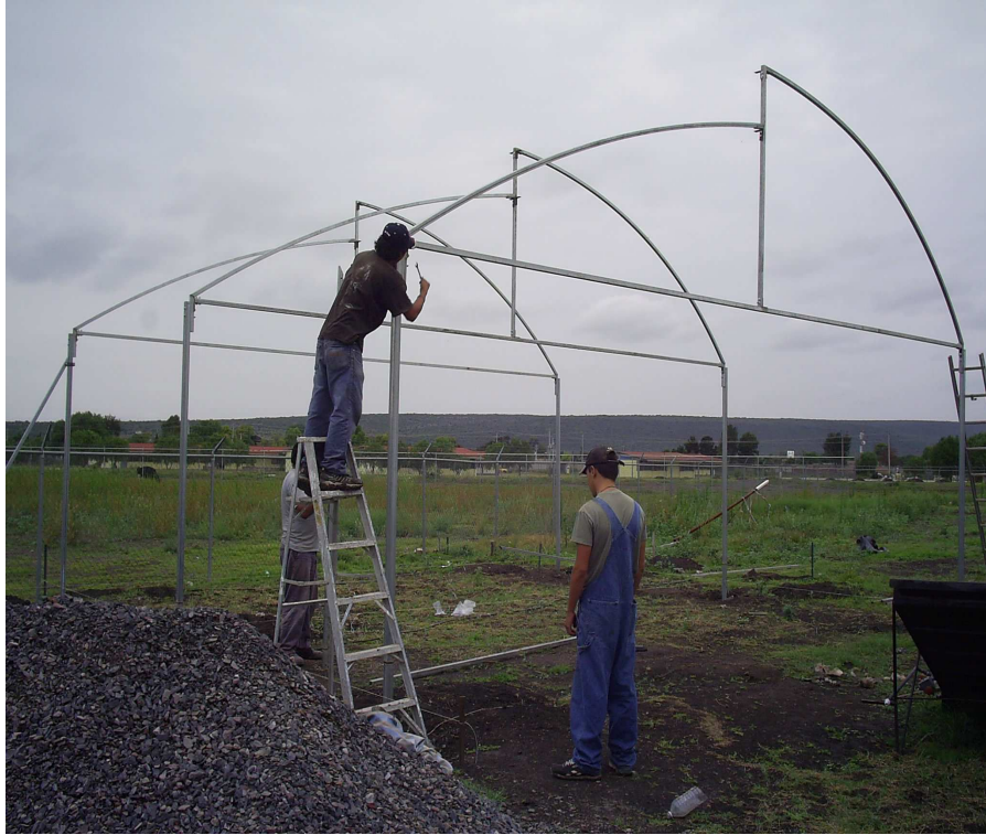
Figura 12. Construcción del invernadero (montaje)
