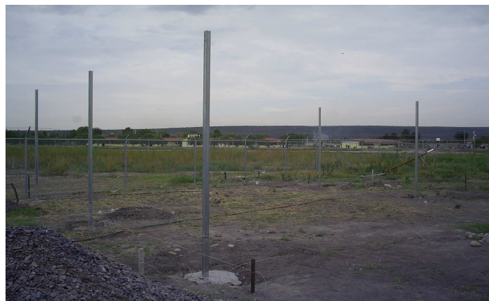
Figura 11. Construcción del invernadero (cimentación)
