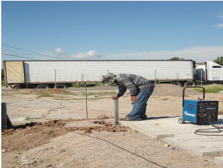
Figura 34. Construcción de la cimentación
