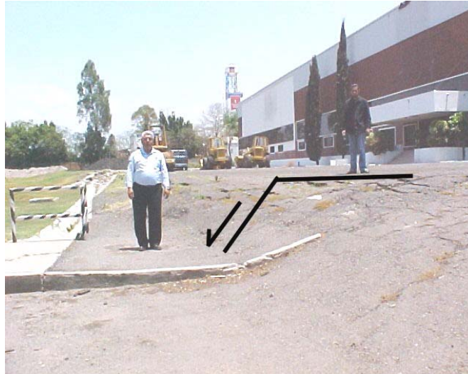
Figura 3.11 Fallamiento 5 de Febrero en el predio de la antigua planta Singer, el cual en 2004 presentaba un desplazamiento vertical de cerca de un metro
