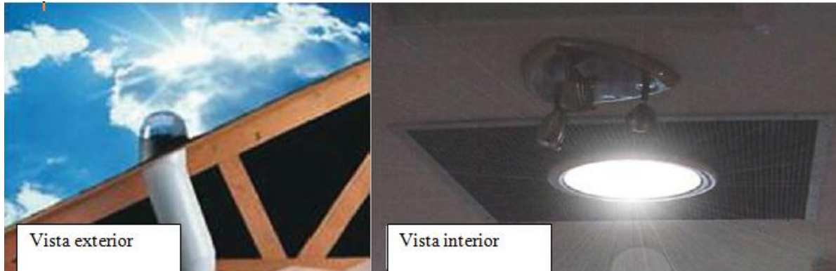
Figura 1.8 Tubo solar para iluminación interior (Han, et al., 2010).
