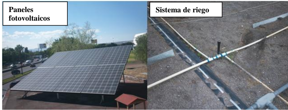
Figura 3.2 a Azotea del edificio H.
