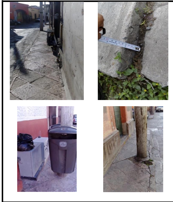
Figura 4.30. Infraestructura presente en la zona conurbada de Querétaro
