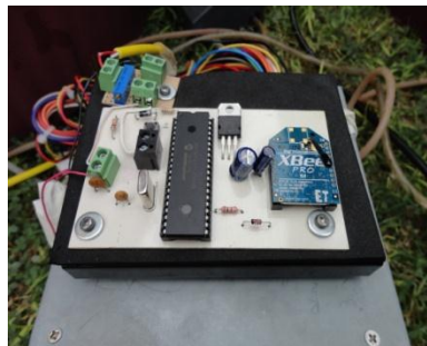
Figura 33. Instalación del módulo emisor.
