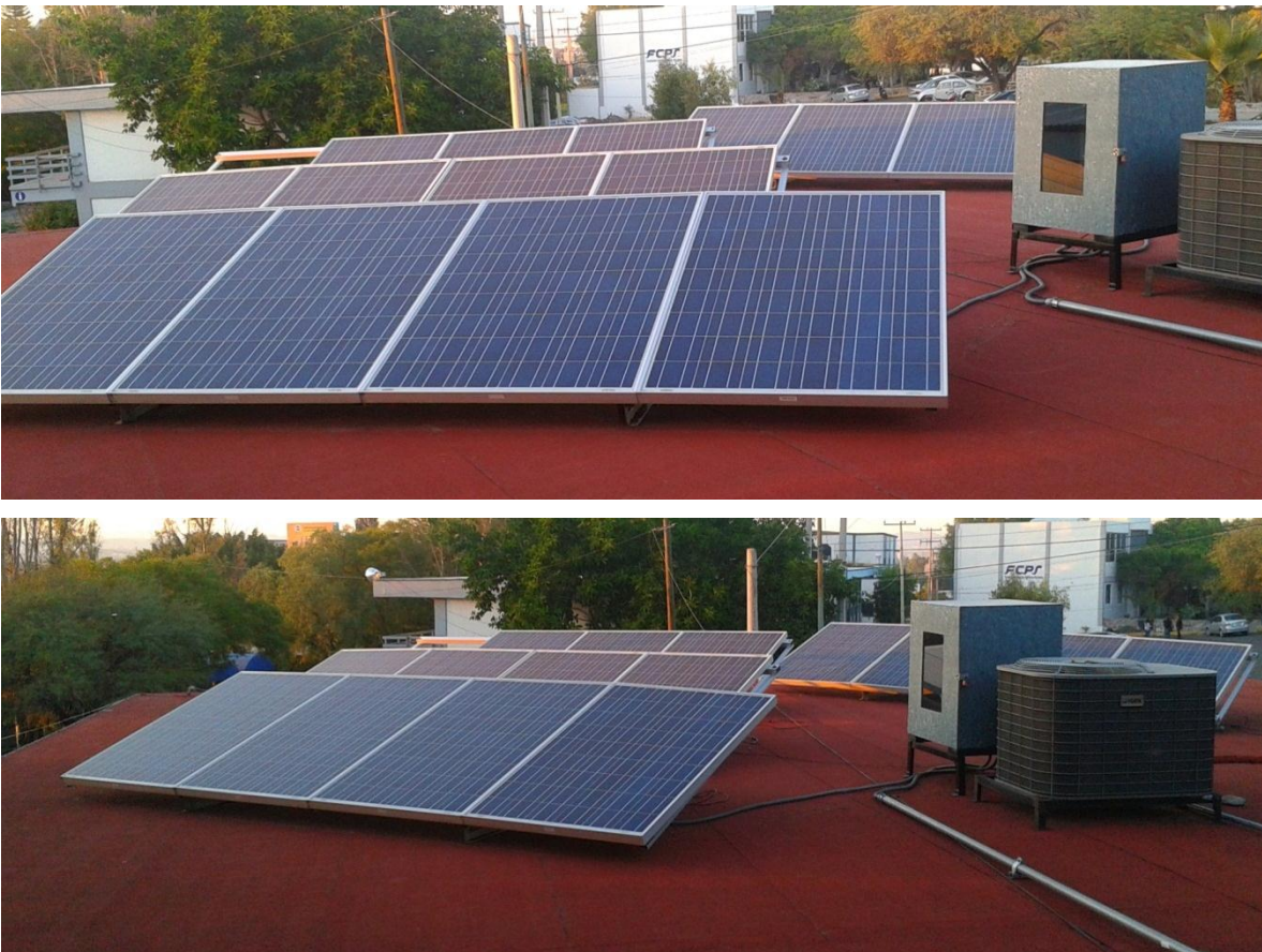
Figura 3.2. Montaje de sistema Fotovoltaico.
