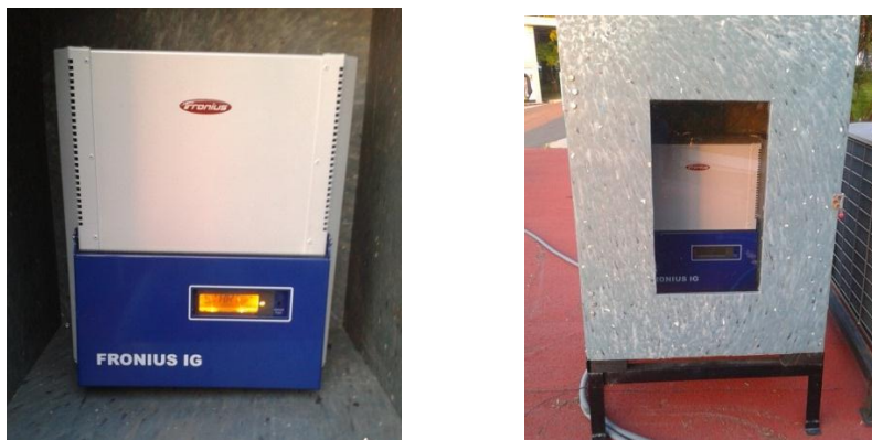
Figura 3.1.6.1. Instalación de inversor
