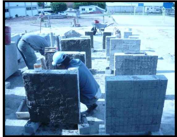
Figura 36. Colocación del mortero de recubrimiento en los muretes.
