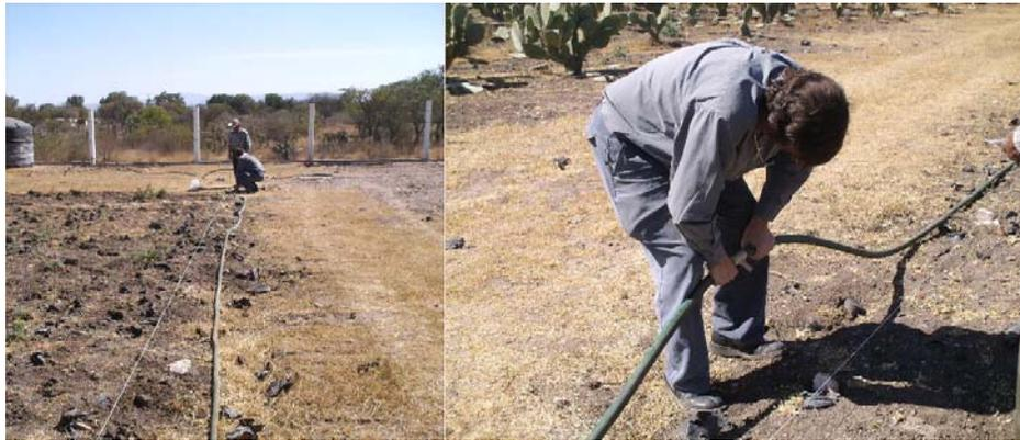
Figura 11. Colocación de la toma principal
