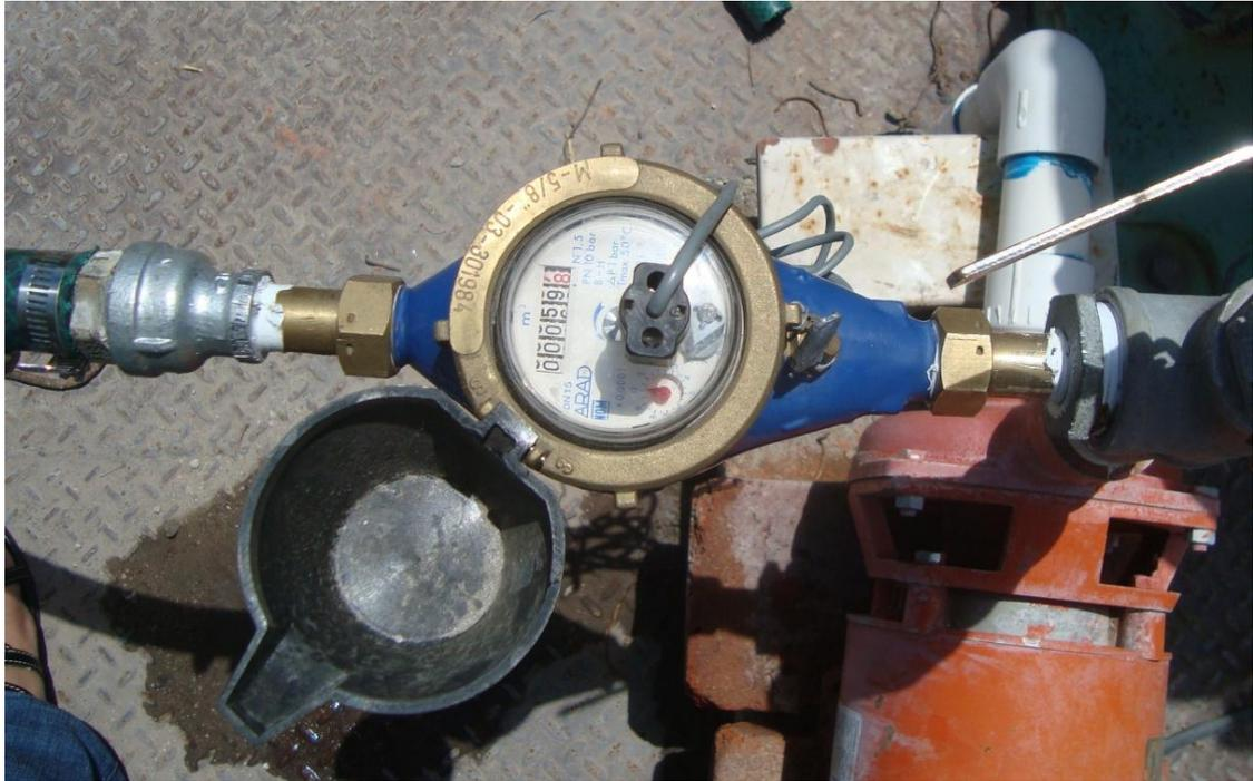
Figura 3.2 Medidor de Flujo instalado en toma de agua para riego manual.
