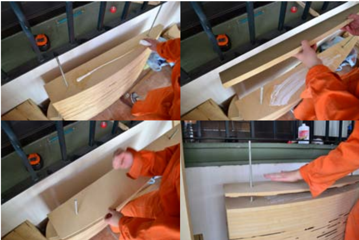
Fig. 37. Armado de planos seriados para formar el molde.
