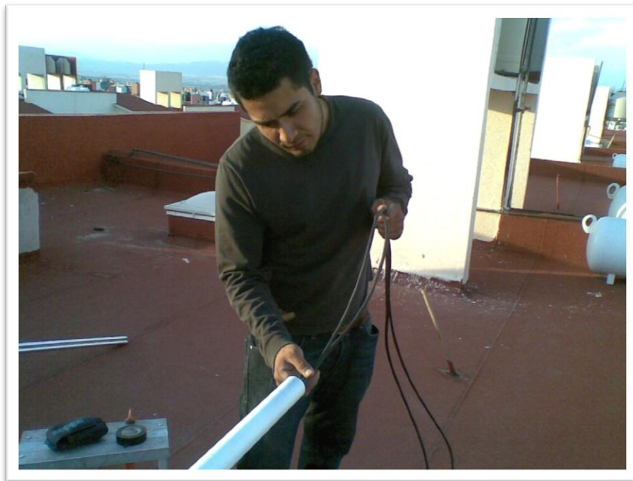
Figura 3.4 Ayuda visual Introducción de cables a tubo conduit
