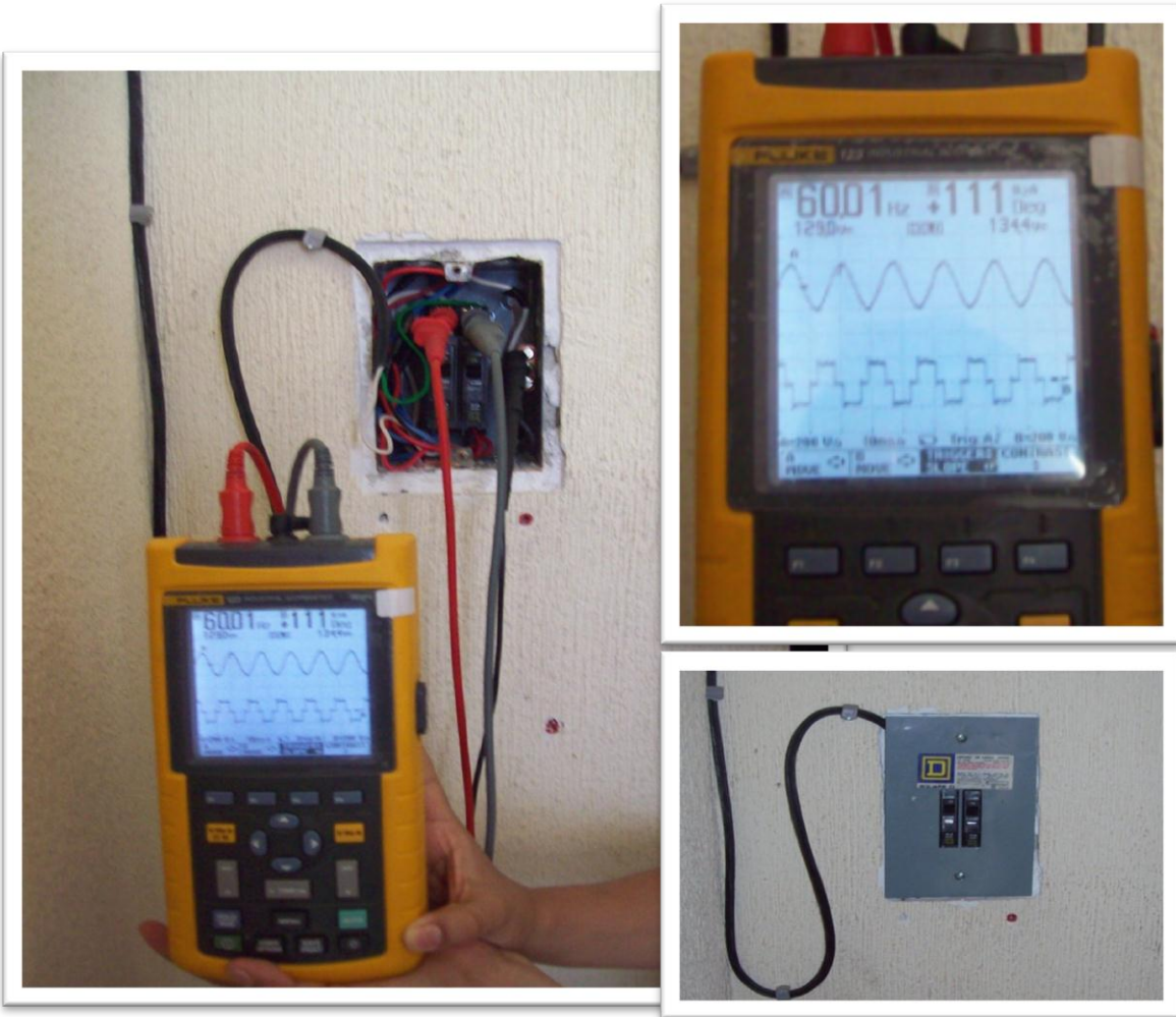
Figura 3.18 Conclusión y Verificación de Voltaje y corriente Nominal
