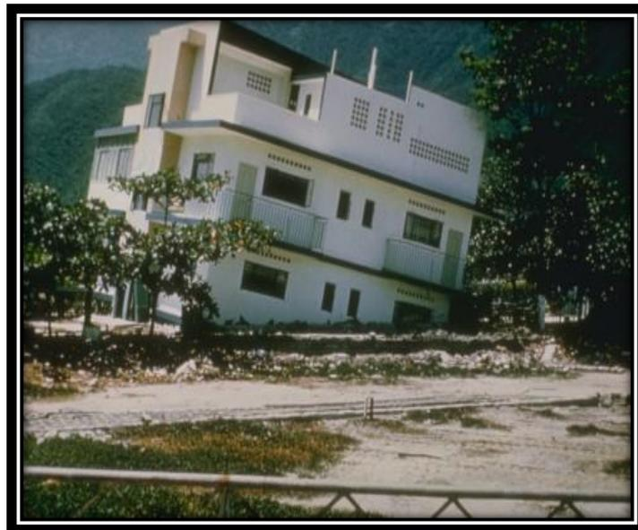
Figura 2. Hundimiento en construcción debida a suelos parcialmente saturados.
